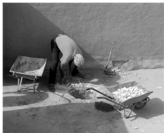
Préparation des drains dans les zones sensibles à l'érosion pluviale.
