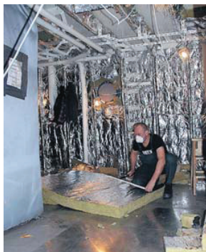
Mit 100 Millimeter dickem Dämmmaterial werden die Außenwände der „Alex“ unter Deck isoliert.
