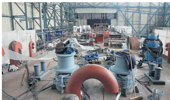
Noch keine Spur von Segelschiffromantik auf dem Deck der „Alex“. Auf dem Rohbau wurden schon Ankerspill und Festmach-Poller montiert.
