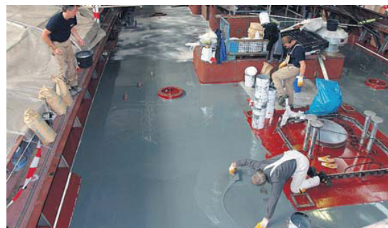
Auf dem Hauptdeck wird eine Ausgleichsmasse aufgetragen. Anschließend erhält der Boden eine weitere Beschichtung, die optisch wie Schiffsbodenplanken aussieht.
