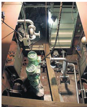
Blick in den Maschinenraum: Hier wird in Bremerhaven eine 551 kW (rund 749 PS) starke Volvo-Penta-Maschine eingebaut.
