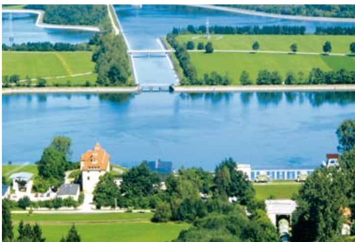
(l.) Die Maschinenhalle im Leitzachwerk 2.
