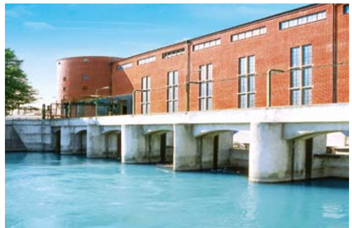
(o.) Der Turbinenauslauf beim Uppenbornwerk 1. (u.) Die Pumpstation Apoig.
