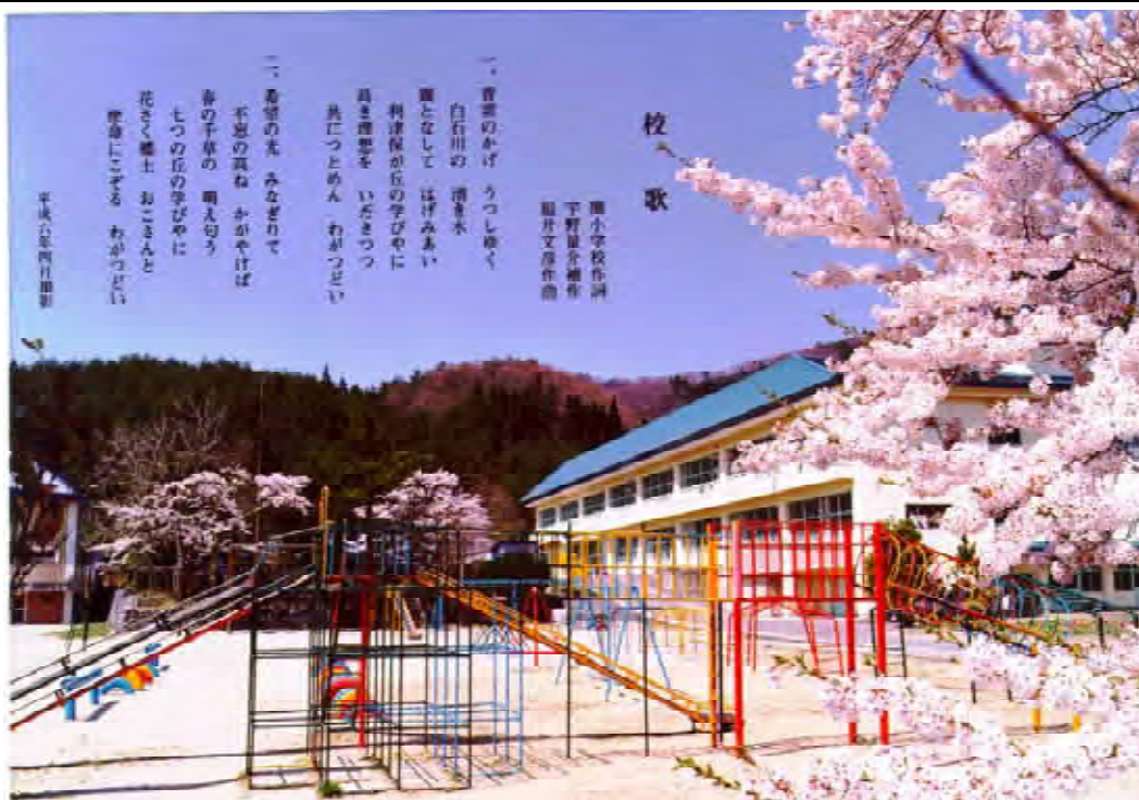
宮城県刈田郡七ヶ宿町立関小学校
