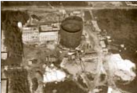
Een zicht op de bouw van BR2 vanuit de lucht
