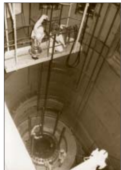
Het inbrengen van de splijstofbundels in BR3 in 1963
