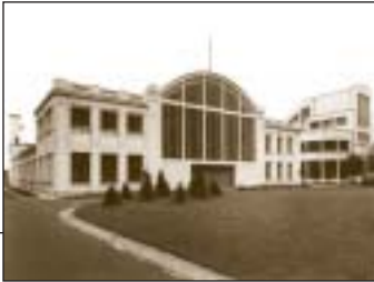
De gebouwen in Sint-Genesius-Rode behoren nu toe aan het von Karman Instituut voor Stromingsdynamica. (Foto von Karman Instituut)
