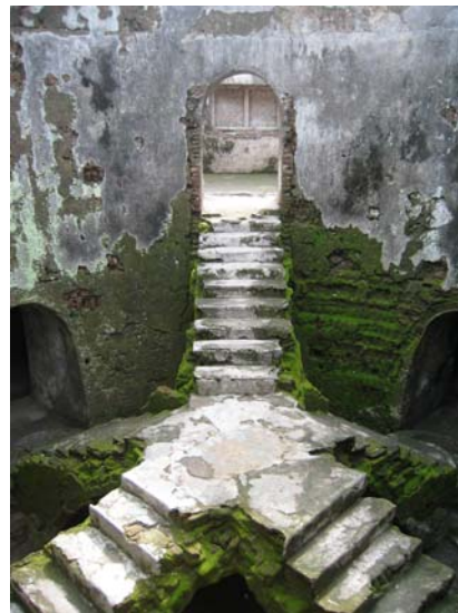
Fig. 7. Sumur Gemuling, l'escalier à cinq volées et l'entrée unique vers la galerie supérieure (coll. de l'auteur).
