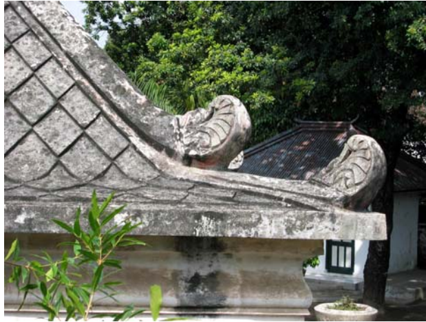
Fig. 10. Terminaisons de solins de l'un des pavillons de plan carré dans la cour octogonale orientale (coll. de l'auteur).
