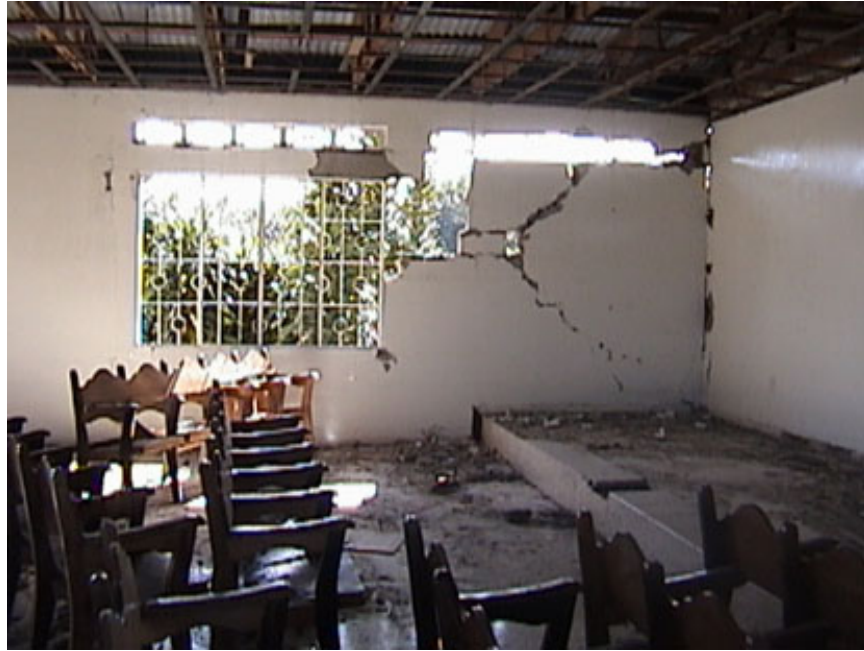
Daños por el terremoto del sismo de Puerto Armuelles de diciembre 2003.
