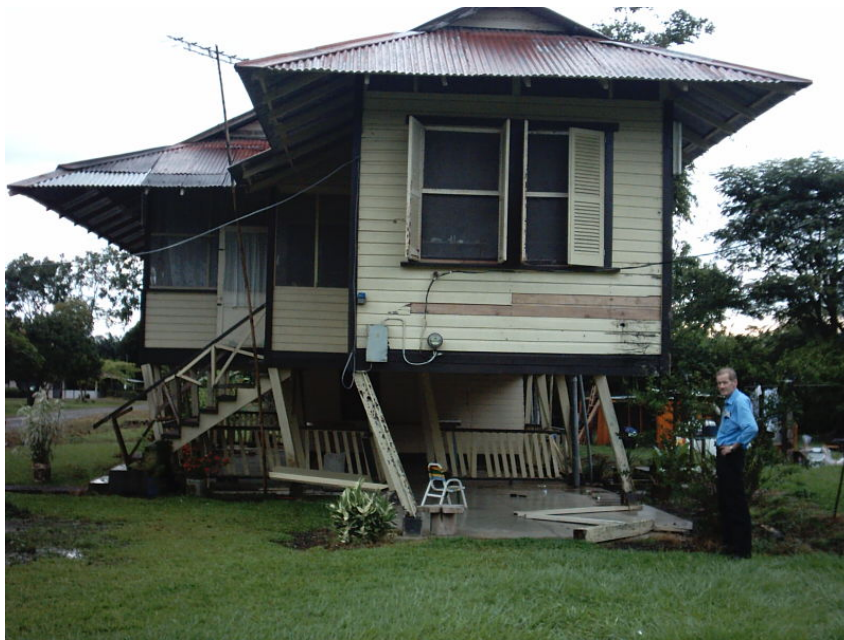
Daños por el terremoto de Damas de noviembre del 2004 (M 6,2)
