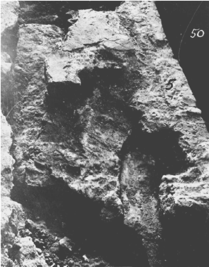
Abb. 22: 1942/43: Mauerwerk des Grabes B050 auf Mauerwerk des Ambo B005
