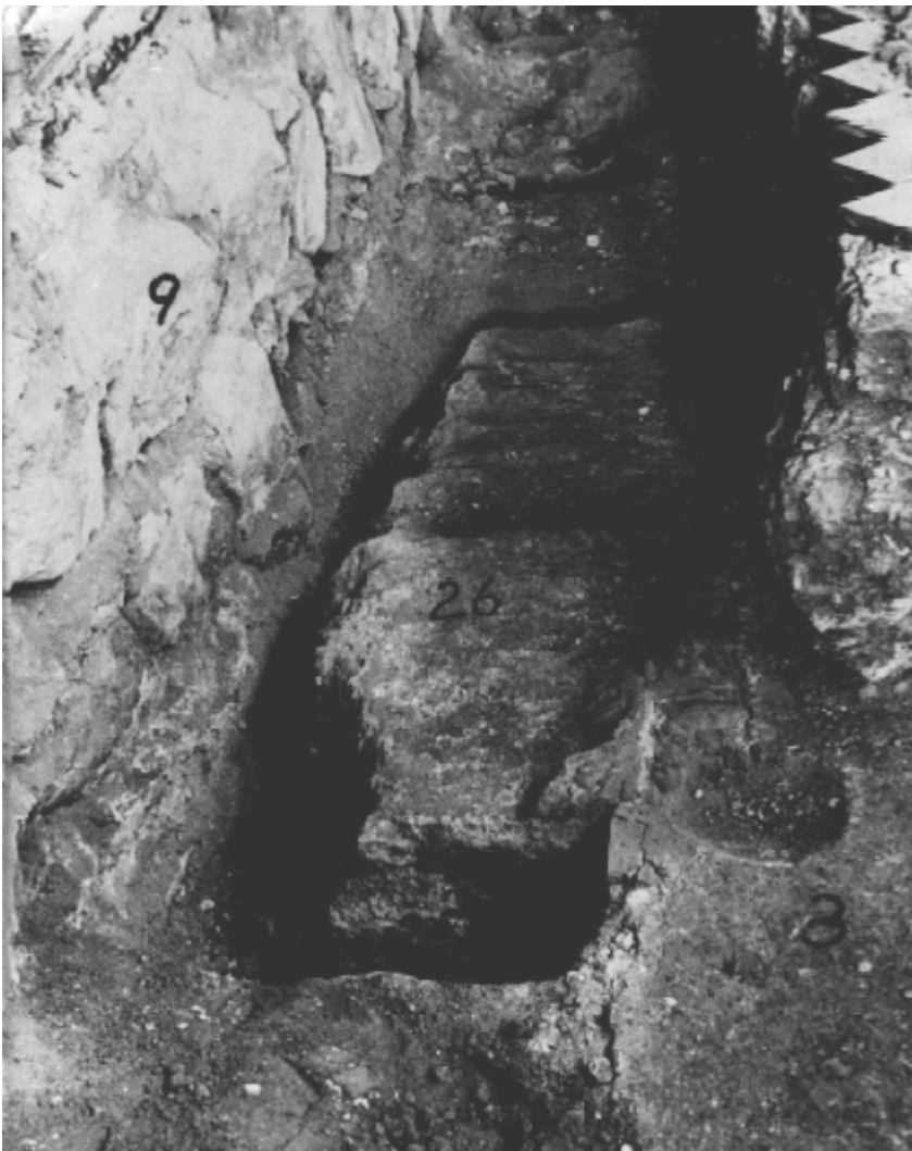
Abb. 50: 1942/43: Stützenfundament B026 an romanischer Grundmauer B009. Von ONO
