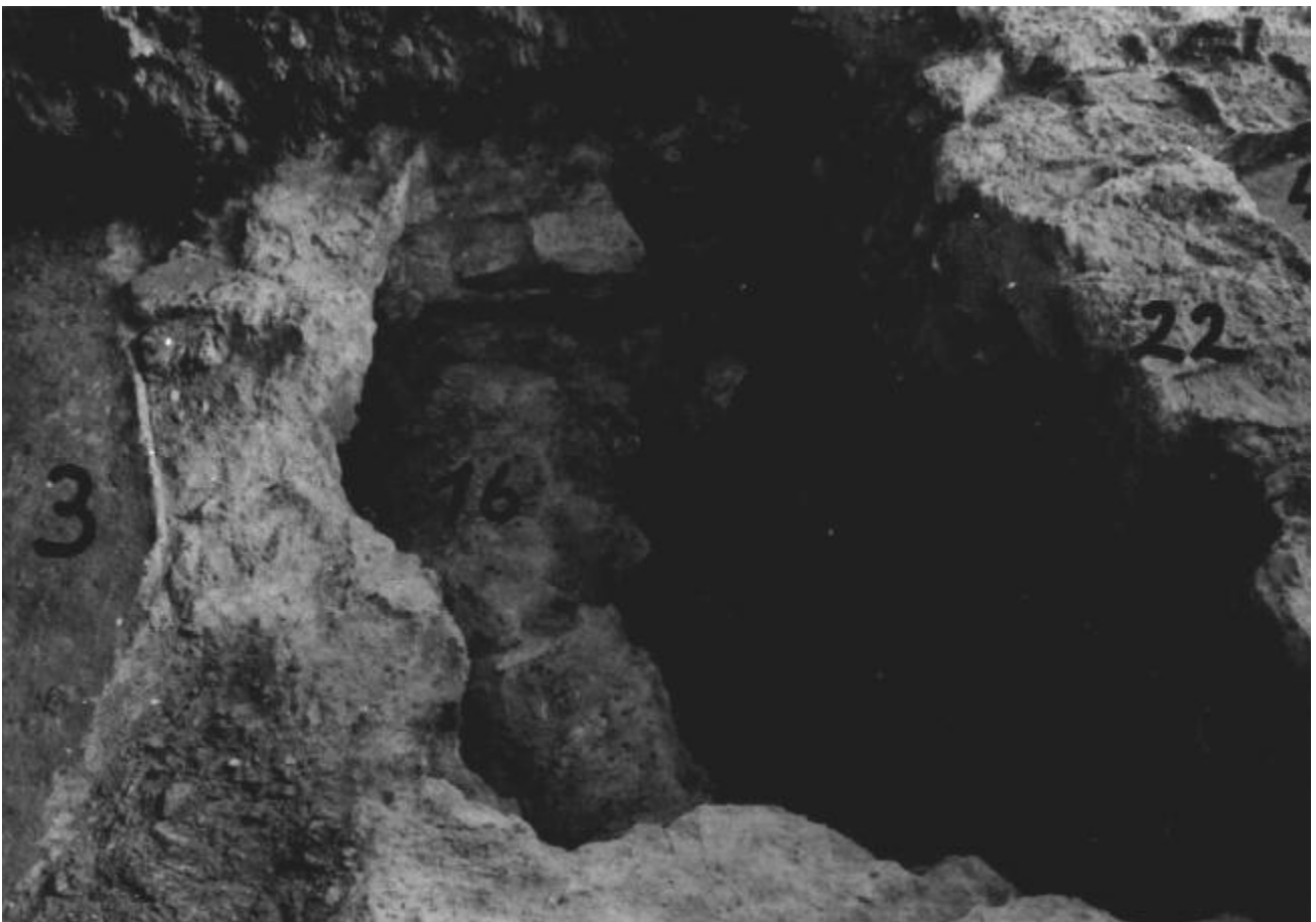
Abb. 51: 1942/43: Ausbruch B514 durch Mauerblock B016. Von SSO
