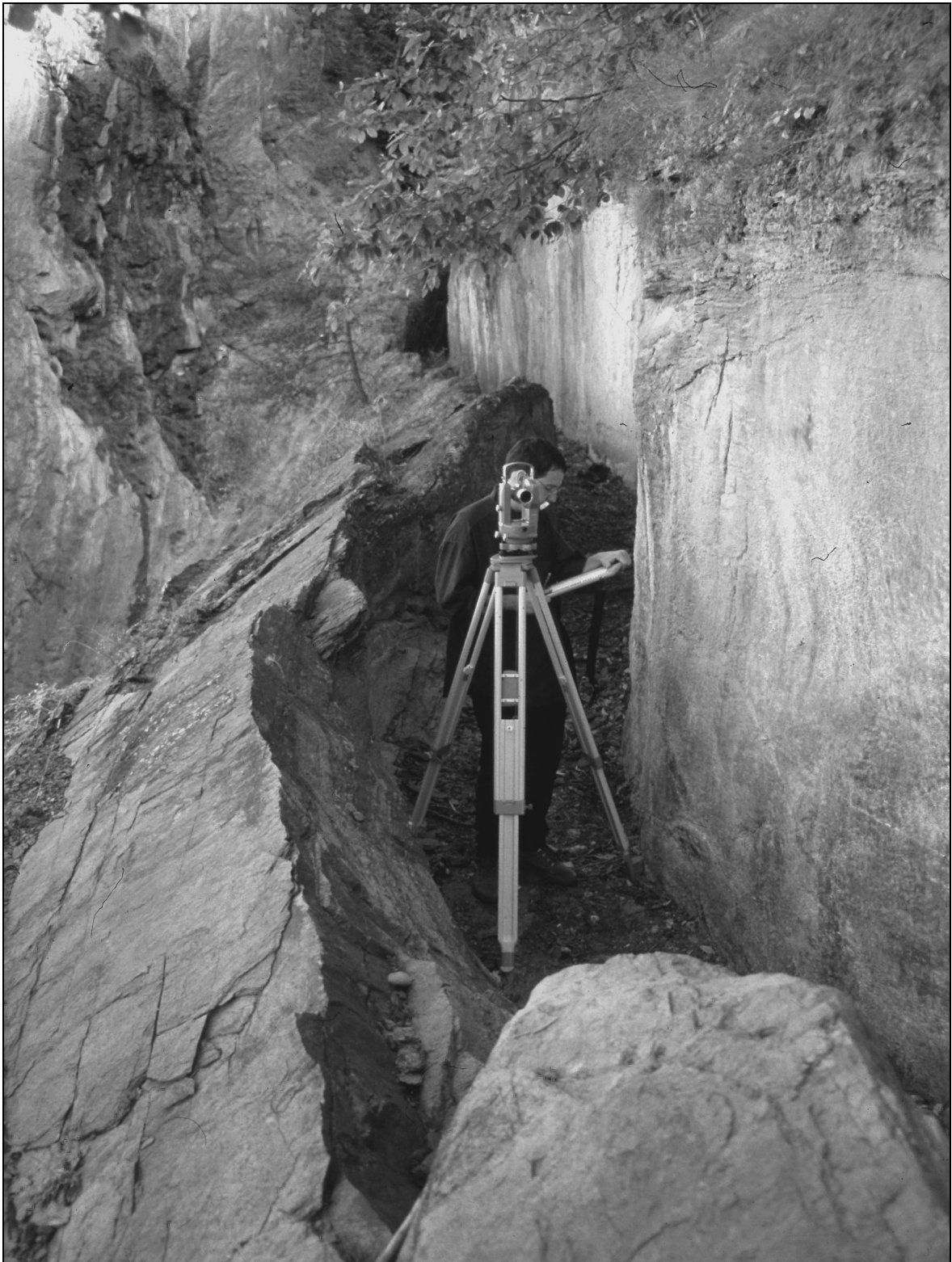
Fig. 3: Aqueduct gallery of Etélei.
