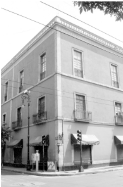
Esquina actual de Donceles y Allende, antes Canoa y El Factor , primera sede formal del Conservatorio (1866-1867)
