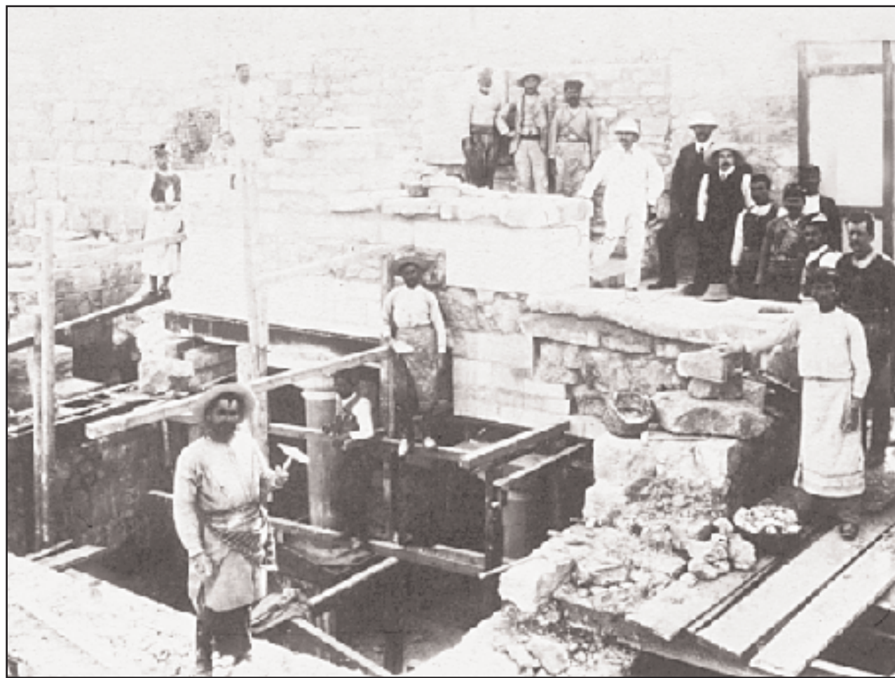
Το πρώτο στάδιο αναστηλωτικών εργασιών στο Μεγάλο Κλιμακοστάσιο (Αρχαιολογικό Μουσείο Ηρακλείου).
