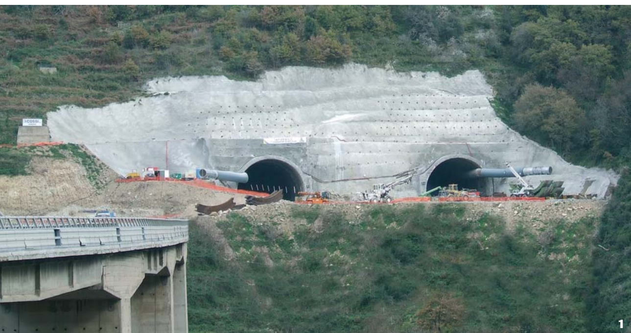
1. Imbocchi Galleria Naturale Muro SUD
