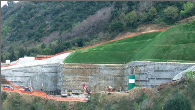
12. Imbocchi Sud Galleria Costaviola
