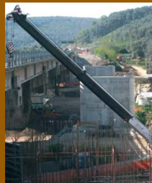
10. Realizzazione pile del nuovo Viadotto Suola Agraria
