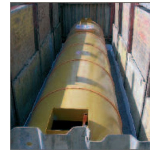
Ouvrage de dépollution enterré :
