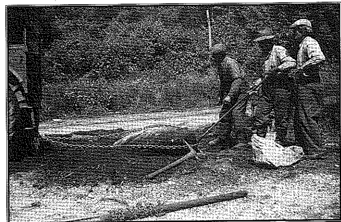
Travaux de construction de l'ancienne route vers Ville-Marie.
