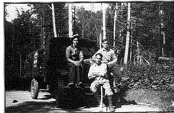
Théodore et Laurent Vaillancourt travaillent à la construction du chemin conduisant à Ville-Marie en 1930.
