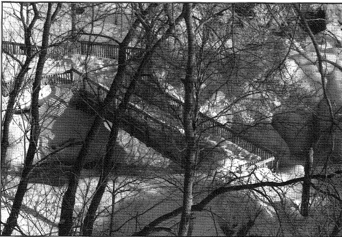
Pont construit au dessus des chutes du ruisseau Gordon, faisant partie de la piste linéaire.
