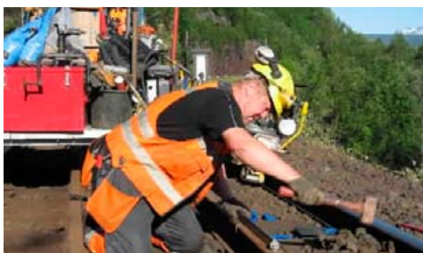
Vedlikeholdsarbeid på Ofotbanen, juli 2007. Foto: Thor Brækkan
