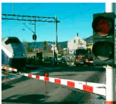
Planovergang med automatisk heilbomanlegg. Foto: Njål Svingheim
