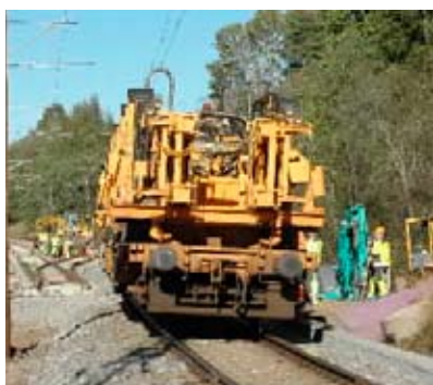
Skinneleggingsmaskin ved Roven kryssingsspor. Foto: Magne Hamar
