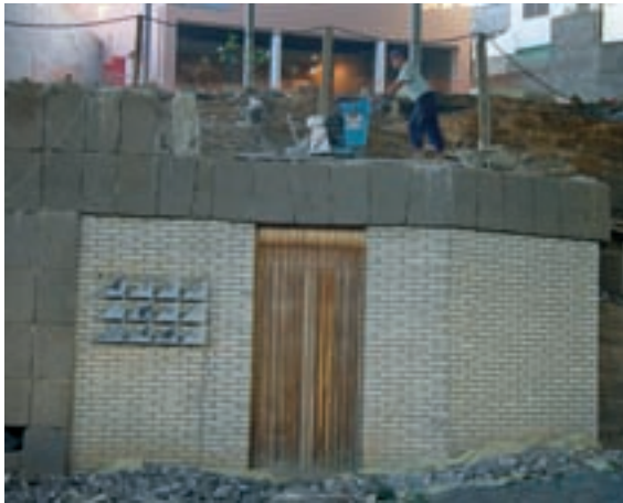
■ Fotos 14. Demolición controlada del forjado superior.
