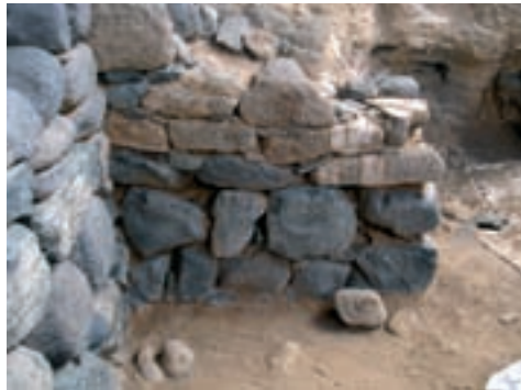
■ Foto 6. Muro de toba, basalto y argamasa de barro.
