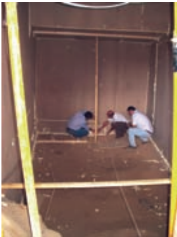
■ Fotos 17 y 18. Replanteo de la «burbuja» dentro del cierre de madera provisional.
