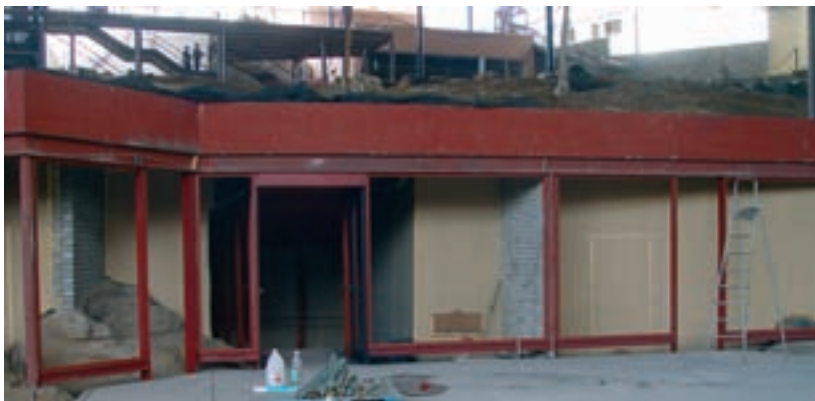
■ Foto 20. Detalle de la instalación de la estructura de la fachada del cierre de la cueva.
