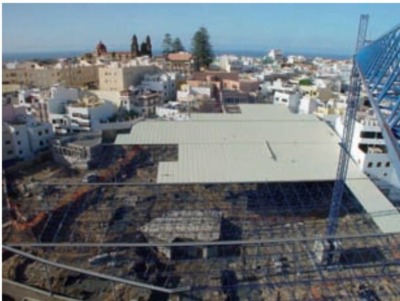
■ Foto 5. Vista elevada del proceso constructivo: cubrición, canalones, estructura y grúa en montaje.
