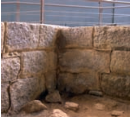
■ Foto 20. Reintegración del muro.
