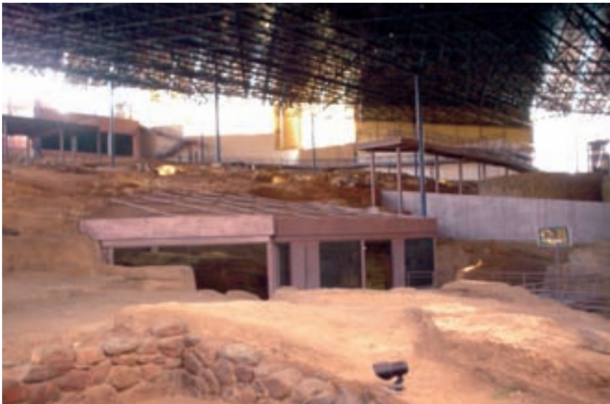
■ Foto 3. Vista del nuevo cerramiento de la Cueva Pintada bajo la cubierta general.
