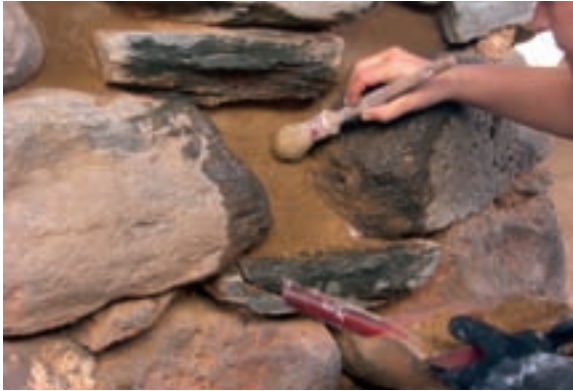
■ Foto 18. Amorteroado y reintegración de un muro de basalto.
