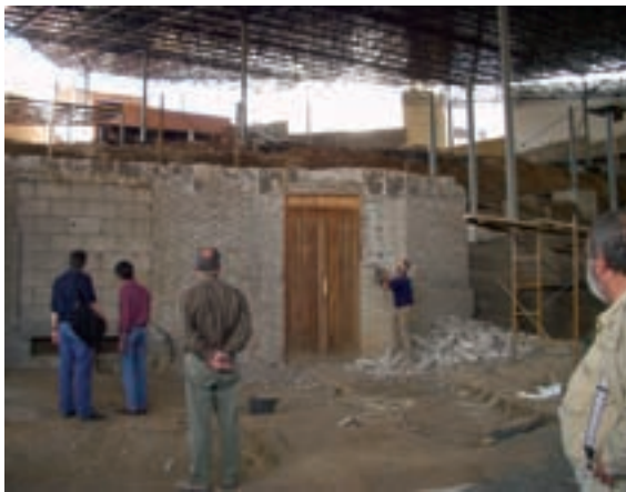
■ Fotos 15. Detalle del desmonte de la fachada.
