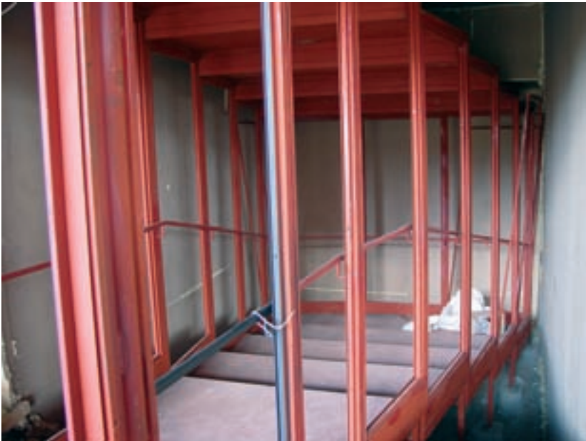
■ Foto 19. Estructura completa de la «burbuja».
