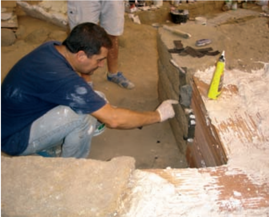
■ Foto 22. Delimitación entre material original y reconstruida.
