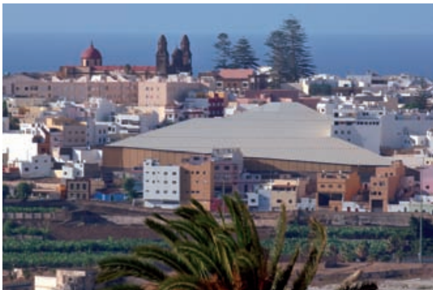
■ Foto 6. Vista dentro del alzado urbano de la cubierta completa.
