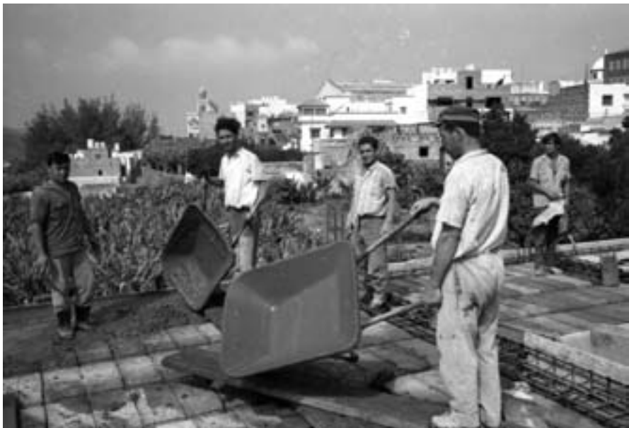
■ Foto 12. Construcción de la plancha de hormigón con la que se cubre la Cueva Pintada después de los trabajos de 1970.
