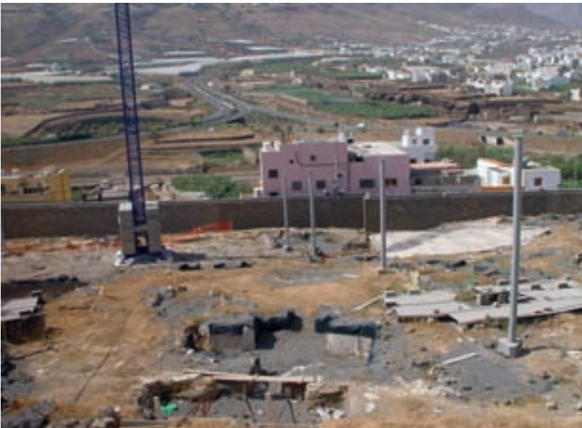
■ Foto 3. Grúa posicionada y pilares colocados sobre encepados.
