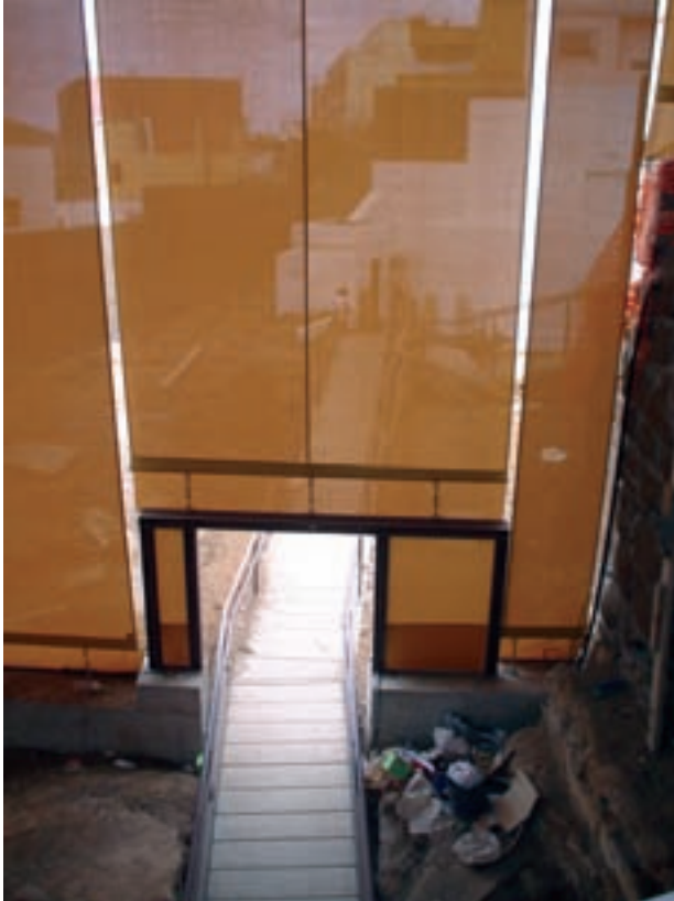
■ Foto 10. Salidas de evacuación o emergencia.
