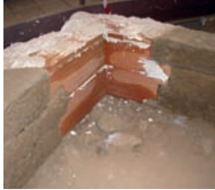
■ Foto 21. Reconstrucción de muros.
