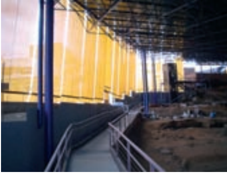
■ Fotos 7 y 8. Los cerramientos laterales.
