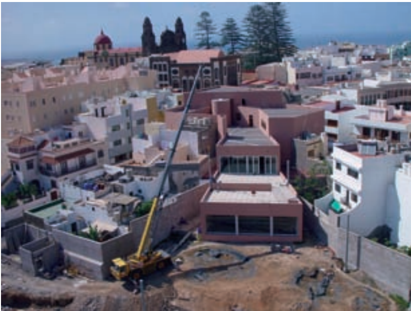
■ Foto 4. Primeros pasos del montaje de la estructura de cubierta.
