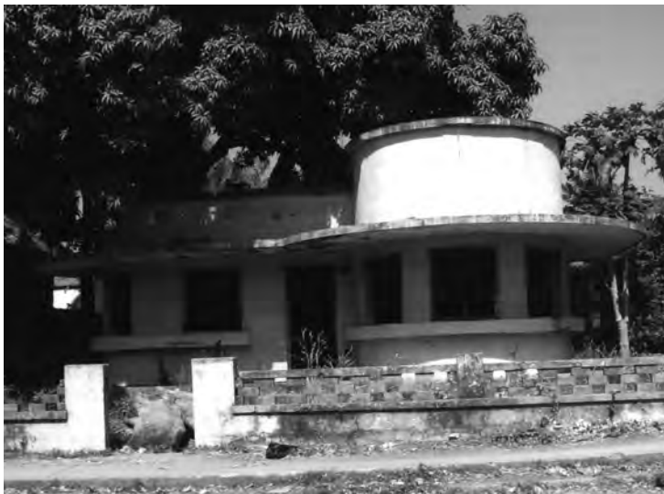
Antiga residência para funcionários, no “Bairro Portugal”.
