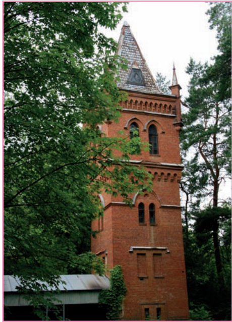
Водонапірна вежа у садибі Наталіївка (Краснокутський район)
