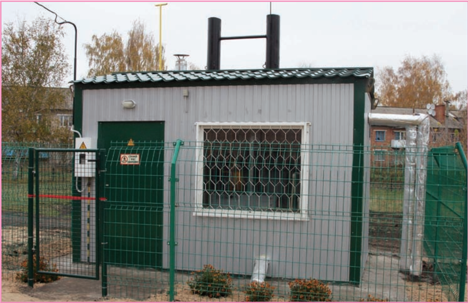
Сучасна котельня загальноосвітньої школи с. Соколове Зміївського району
