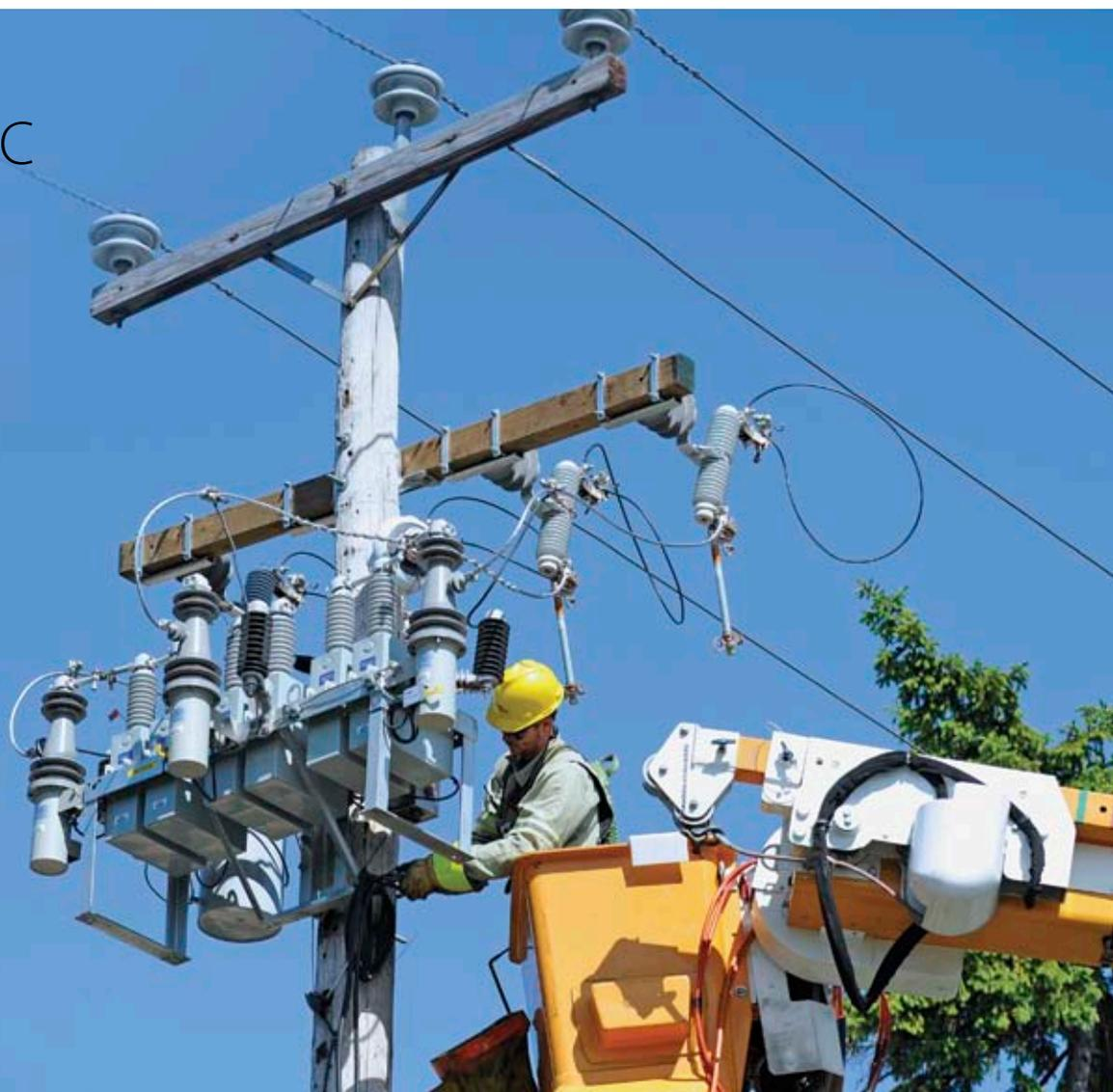
Installation d'une batterie de condensateurs par le monteur Julien Desrochers dans le cadre du projet Addition 1 000 Mvar.
