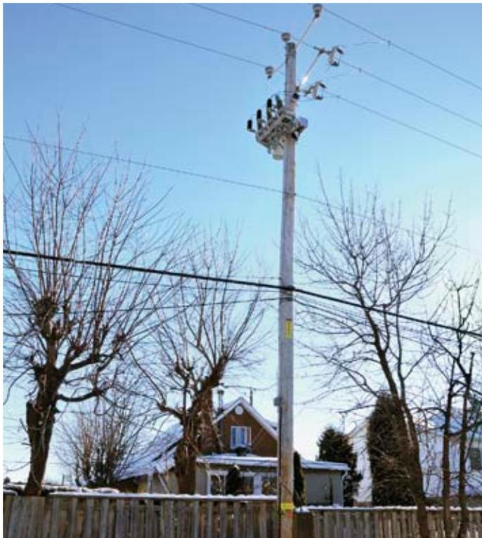
◀ Grâce au projet CATVAR, le réseau de distribution de Saint-Hubert est maintenant équipé de transformateurs télésurveillés.
