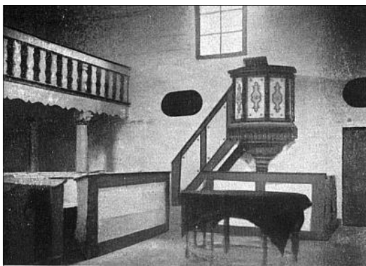
Obr. 13. Hrubá Lhota, interiér toleranční modlitebny, fotografie z poč. 20. stol., postavena r. 1783.
