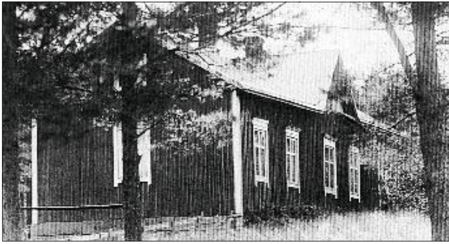
Virolan päärakennus 1930-luvulla kuvattuna. Kuva Kalle Laaksonen
