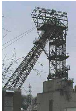
Fördergerüst Delbrück II
