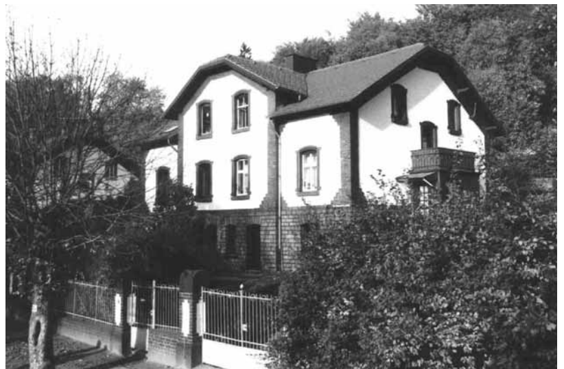
Siedlungshaus für Grubenbeamte
