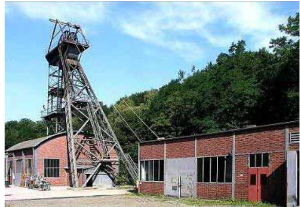
Vorderansicht mit Maschinenhaus
