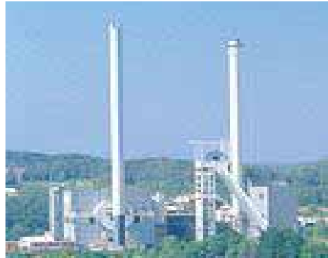
Müllverbrennungsanlage mit Fördergerüst
