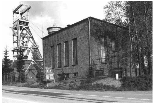
Fördergerüst mit Fördermaschinenhaus
