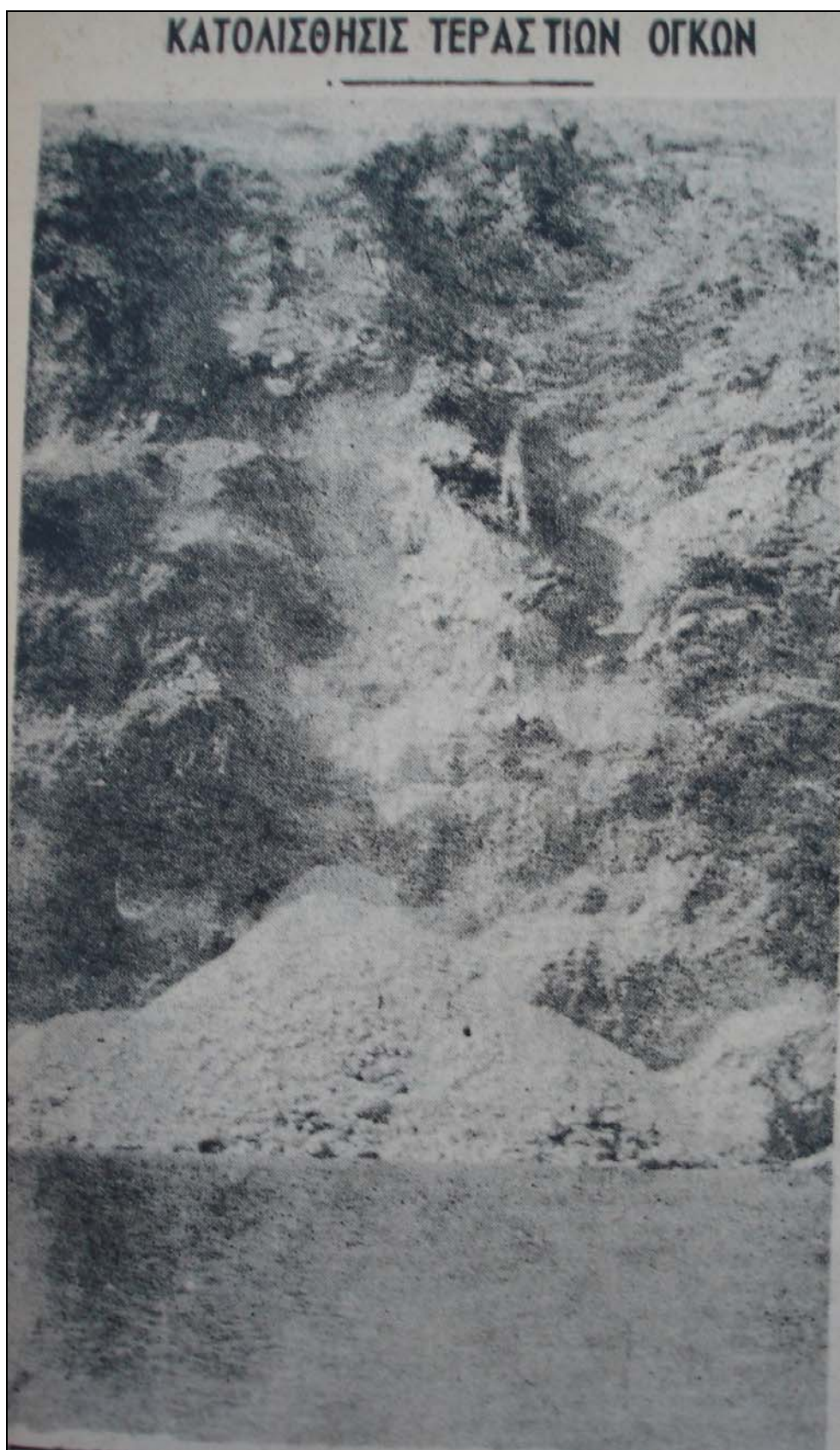
Εικ. 5: Φωτογραφία από κατολίσθηση σε περιοχή της Κεφαλονιάς.
