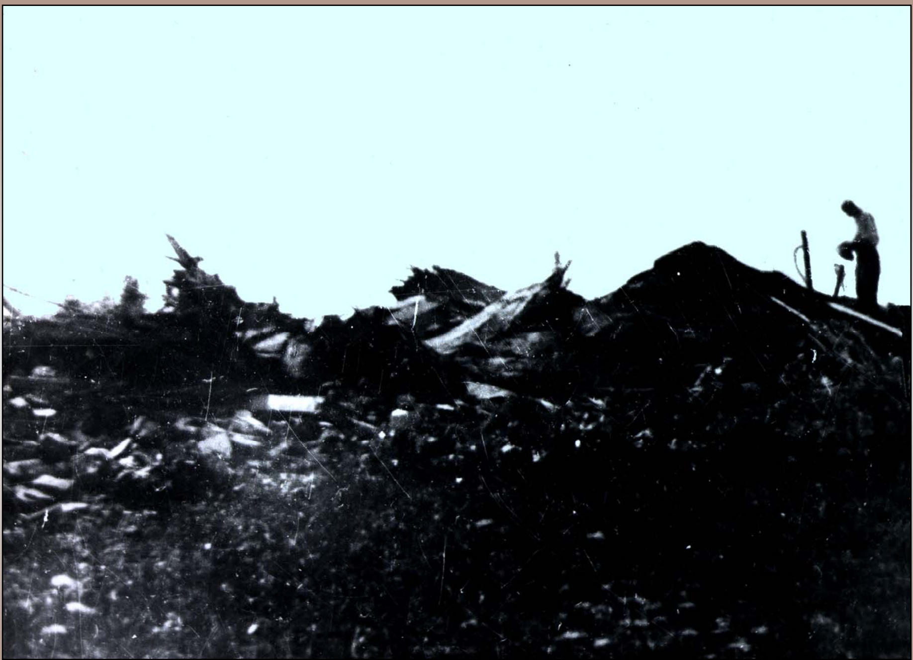
Характерные разрушения построек в эпицентральной области Хаитского землетрясения 10 июля 1949 г.
