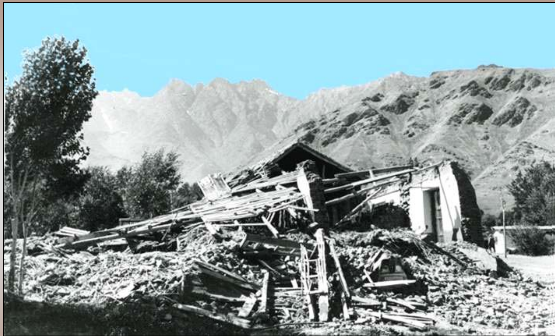
Разрушенные постройки в эпицентральной зоне Хаитского землетрясения 10 июля 1949 г.
