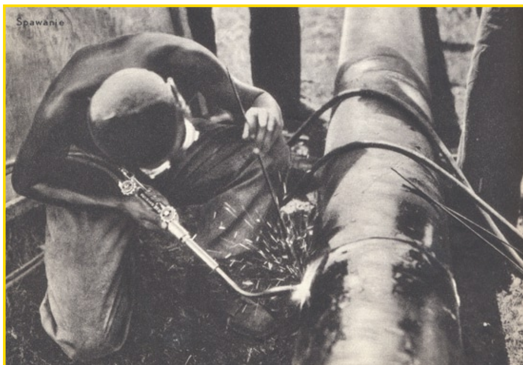
Spawanie rurociągu
