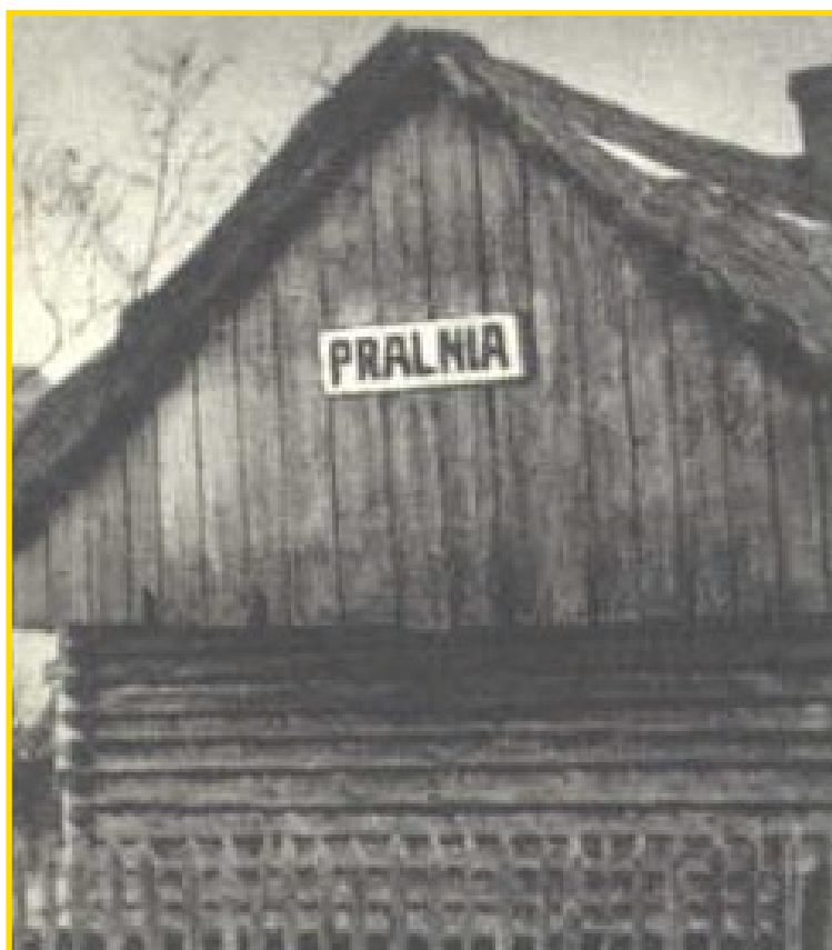
Przyszła „Pralnia centralna” S.A. w Pławiu - na razie...
