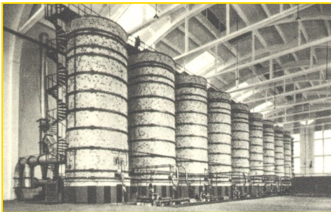
Wieże absorpcyjne systemu Mościckiego
