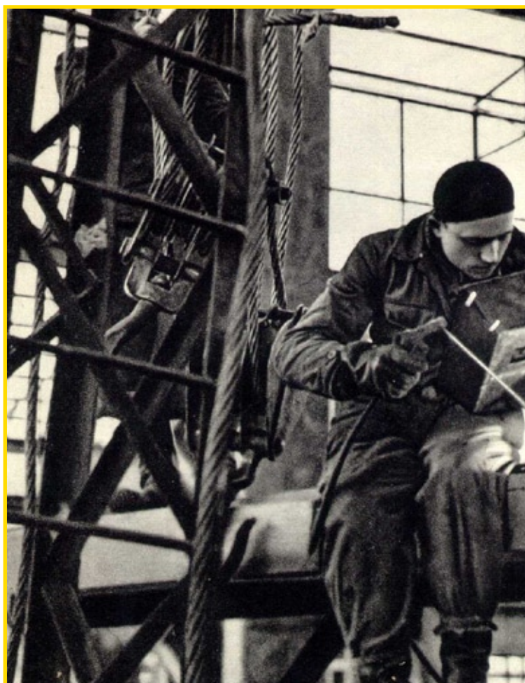
Spawanie stalowych konstrukcji
