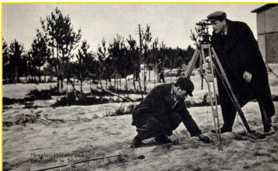
Niwelacja terenu pod budowę pawilonów w Stalowej Woli
