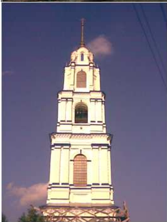
Верхняя часть колокольни церкви Троицы Живоначальной в селе Эрлекс в 2008 году во время штукатурно-малярных работ.
