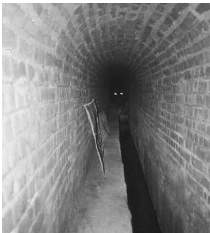
Figure 4. Side gutter. Bajo Abroñigal qanat
