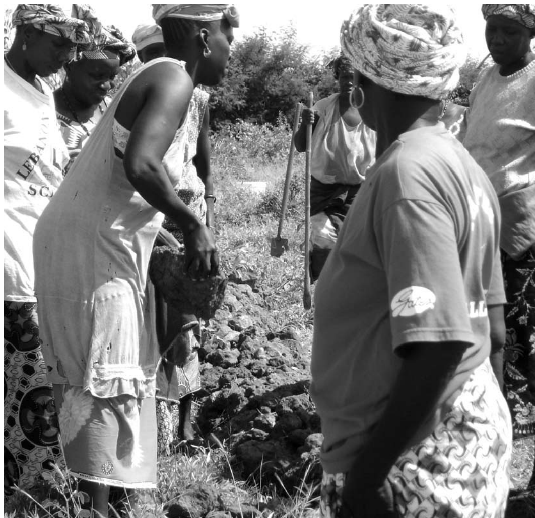
Construction de digues anti-érosives, Landou, Sénégal
