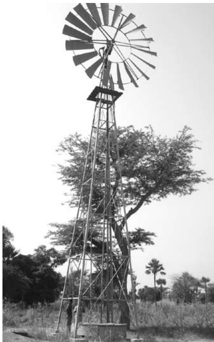
Éolienne pour le pompage d'eau, Thiès, Sénégal
