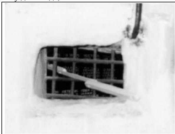
Рис. 100. Зарешеченное отверстие в стене помещения I санитарно-гигиенического здания №41, лагерь Майданек (ср. фрагмент плана здания, рис. 99).
