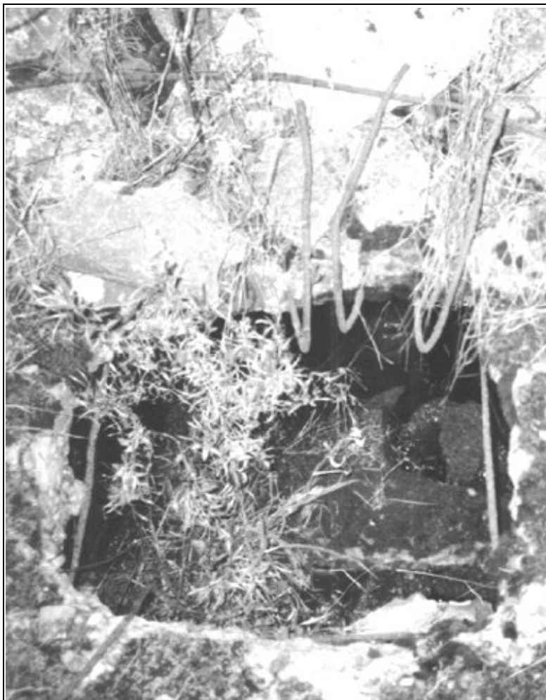
Рис. 65. Предполагаемое отверстие для ввода Циклона-Б в крыше морга 1 («газовой камеры») крематория II. Отчётливо видно, что стальные прутья не были оттуда сняты, а всего лишь отогнуты.
