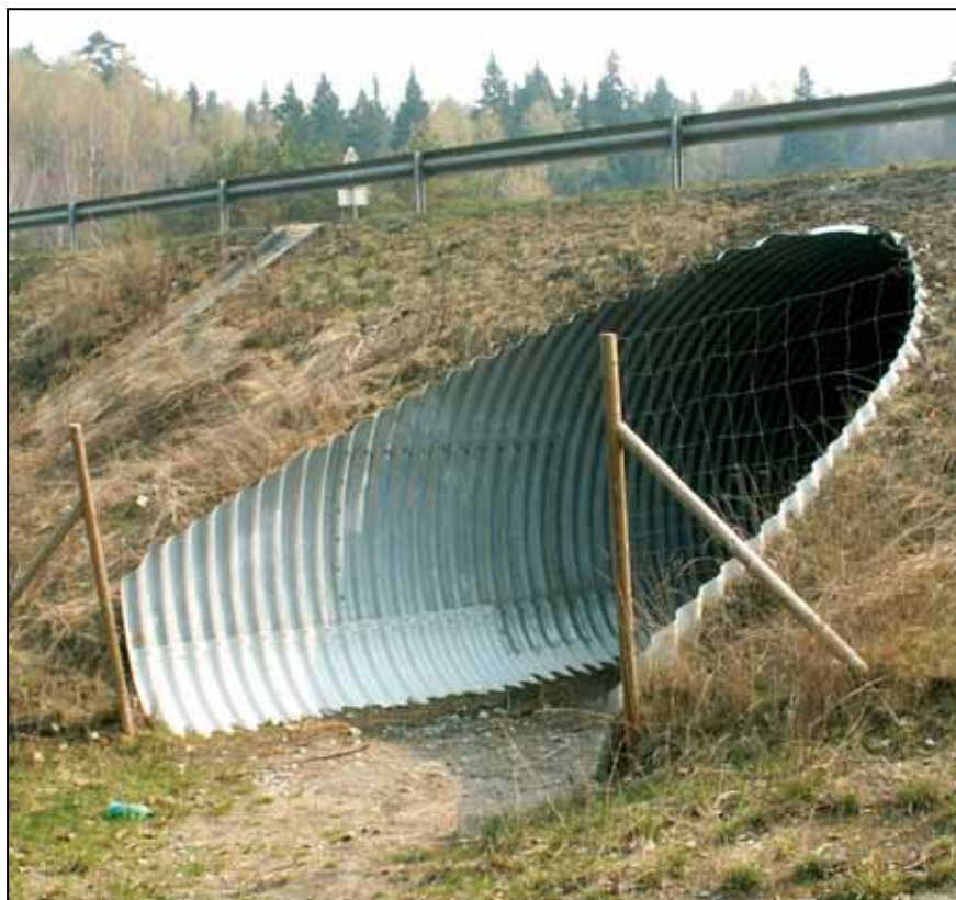
JOONIS 1. LÕPLIKULT VALMIS EHTATUD (SUUNAVATE TARADEGA) LÄBIKÄIK (85,4 KM VILNIUSEST)
