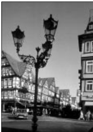
Historische Fachwerkbauten in Celle
