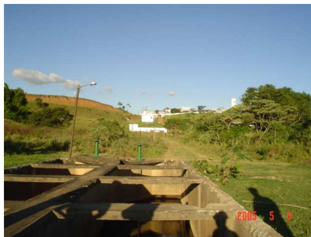
Vista da caixa de areia e ao alto a ETA
