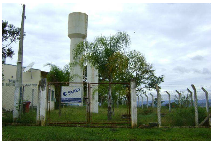
Vista geral do reservatório Parque das Garças
