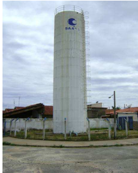
Vista geral do reservatório Vila Municipal
