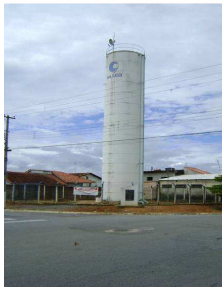
Vista geral do reservatório da Vila dos Comerciantes
