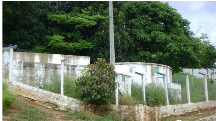
Vista geral do reservatório R-9
