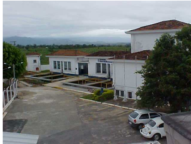
Vista geral da ETA
