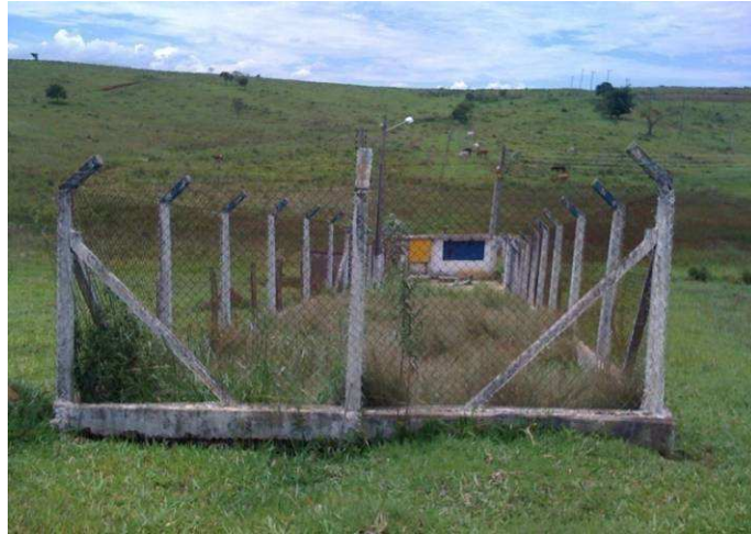
Poço do sistema Montes Verdes
