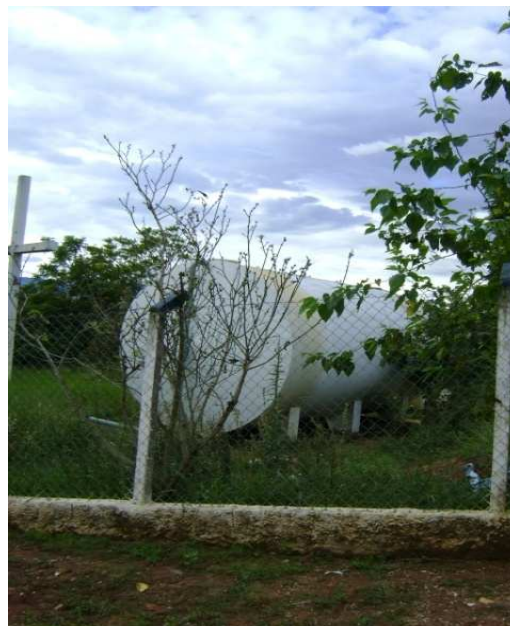
Vista geral do reservatório R-10
