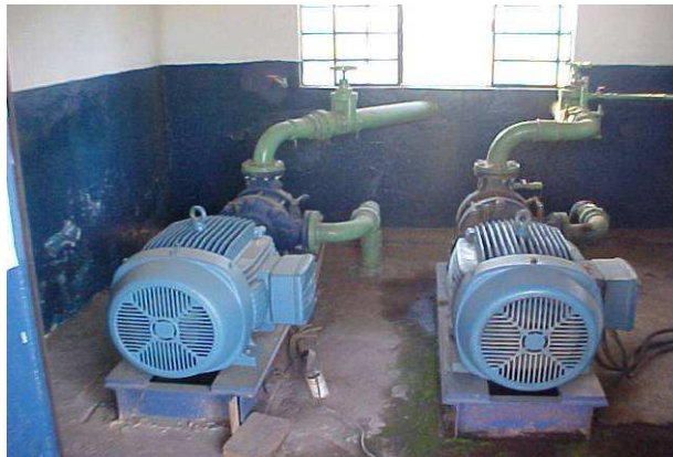
Detalhes da EEAT-6
