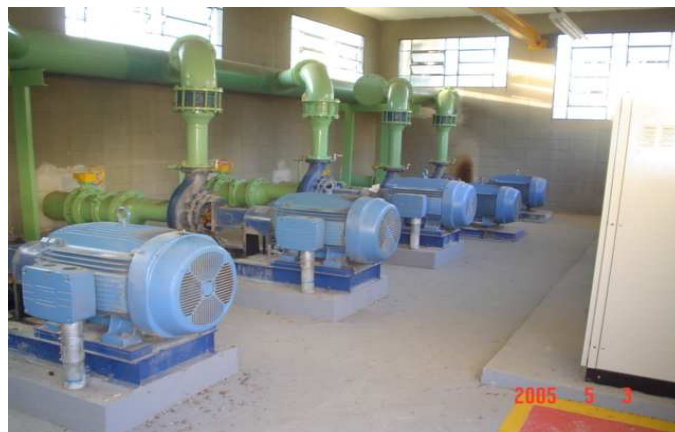
Detalhes da EEAT na área da ETA
