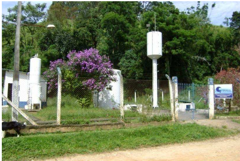
Estação de tratamento de água - Pedrinha
