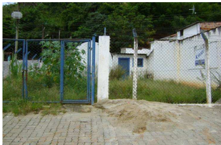
Vista geral estação elevatória EAT7
