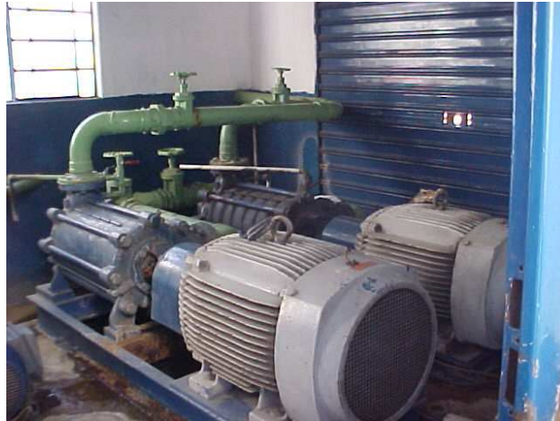
Detalhes da EEAT-4
