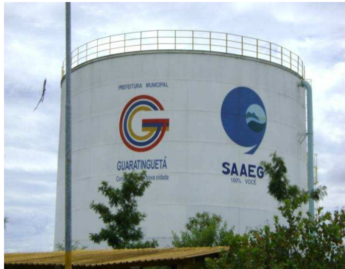
Vista geral do reservatório R-14
