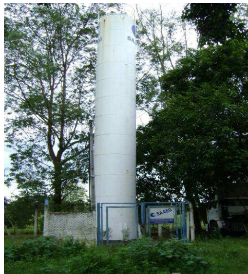
Vista geral do reservatório da Vila Ofélia
