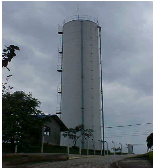
Vista do REL-7 na área da ETA
