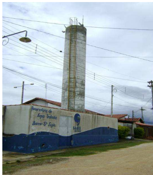
Vista geral do reservatório Santa Luzia
