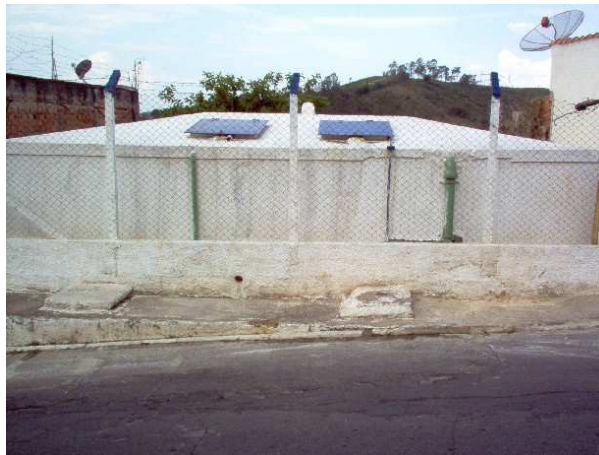
Reservatório R8 – Alto São João
