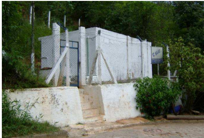
Vista geral do reservatório R-11
