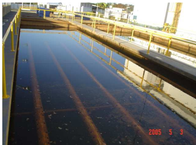
ETA - Tanques de decantação
