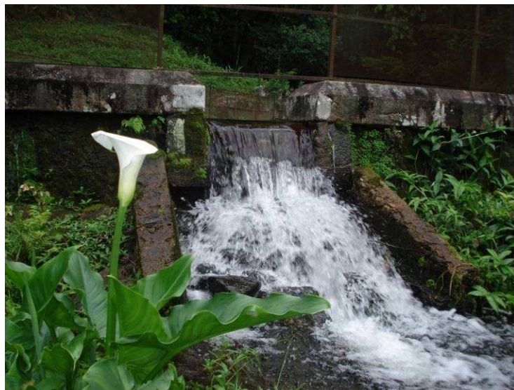
Vista geral da captação do Ribeirão dos Lemes
