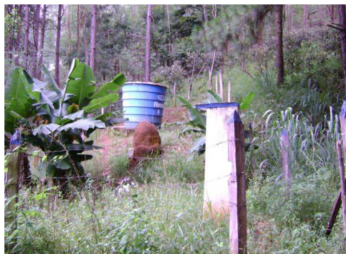
Vista geral do reservatório do Morro Frio
