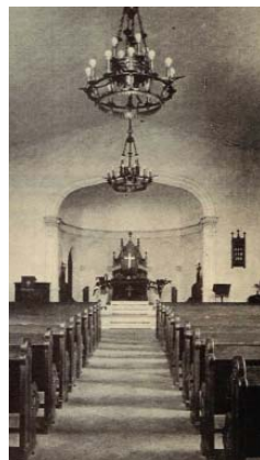
Interior original del Templo. Foto: www.redentor.org.ar
