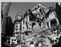
17 de marzo de 1992. Los escombros del edificio de la Embajada de Israel.
