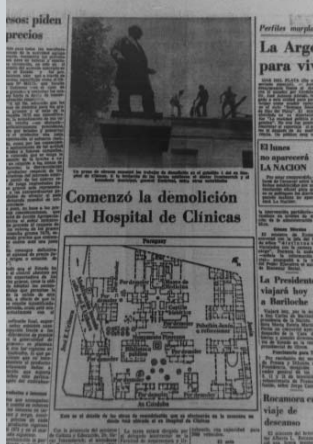
Demolición del Hospital de Clínicas tal cual lo reseña el diario La Nación.
