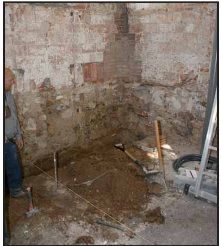
Obres de reforma dels lavabos / Diari Ametlla
