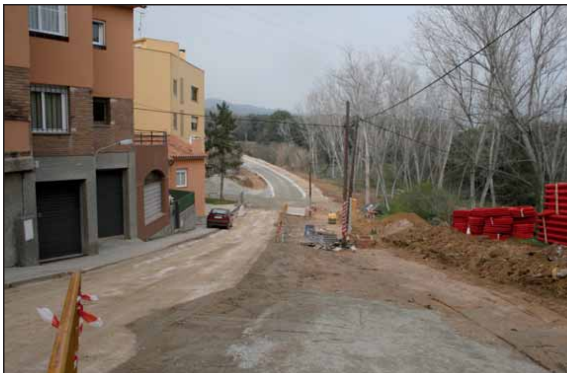
Tram vial de serveis que dona continuïtat a les obres del carrer Alzina
