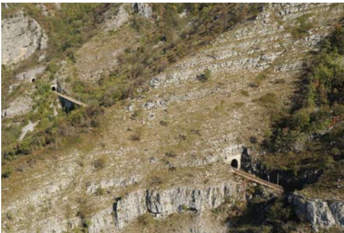
3. Na dijelu pruge Bioče - Bratonožići u blizini mosta na maloj rijeci
