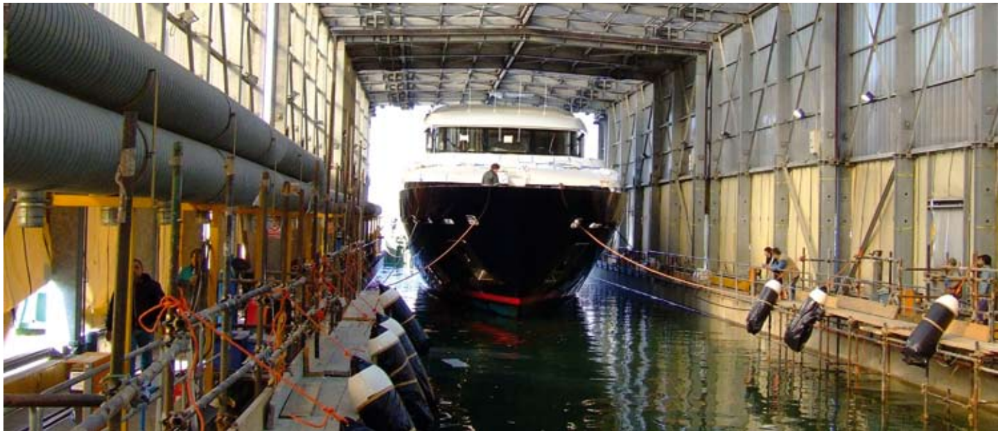
This and previous pages, images of the Collezione Series Yachts under construction in Sarzana shipyard In questa pagina e nelle precedenti, alcune immagini degli Yacht della Serie Collezione in costruzione a Sarzana
