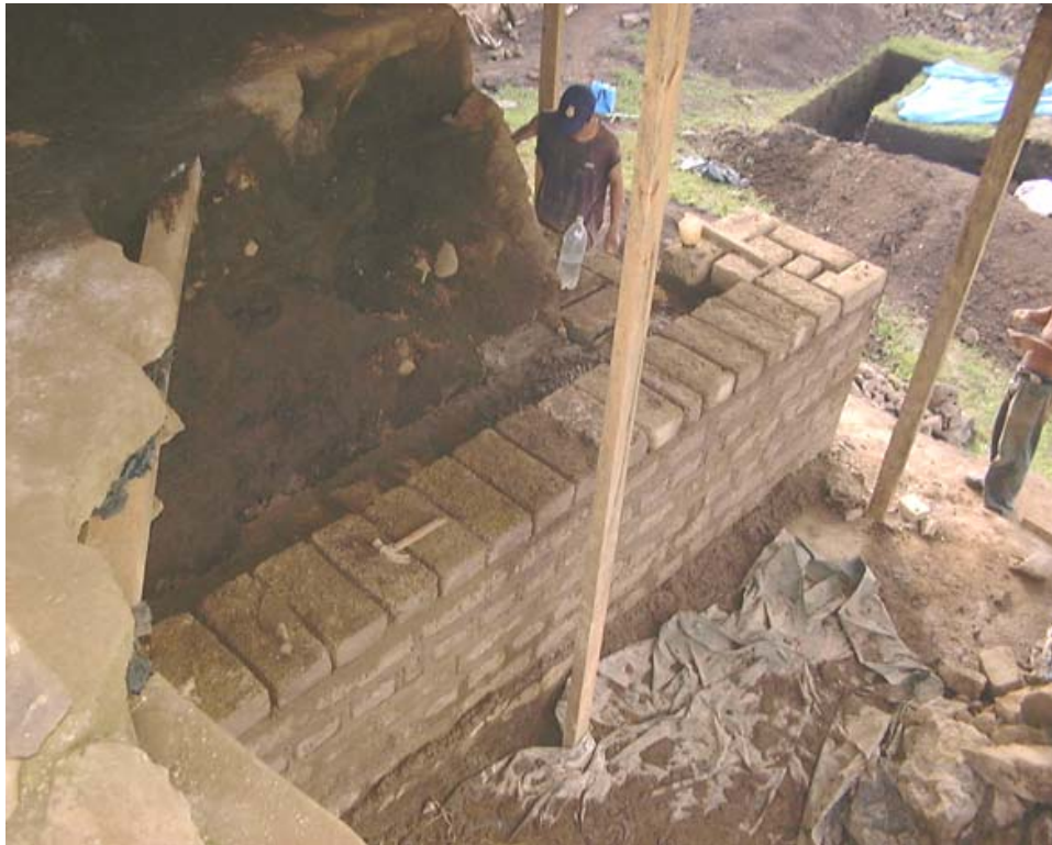
Figura 18 Levantado de muros
