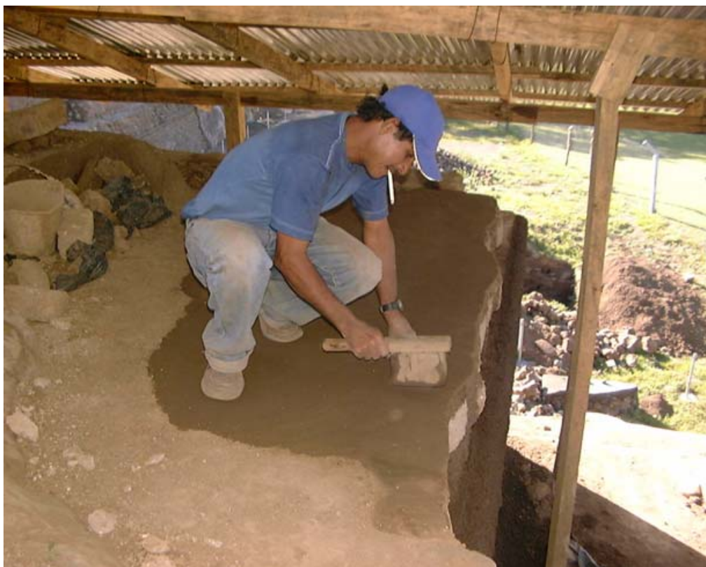
Figura 19 Repello y compactación
