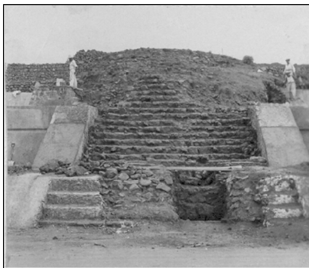
Figura 4 Fachada oeste descubierta por la investigación en la década de 1950 (hacia el este: fotografiada en el 28 de marzo, 1950 por Boggs)
