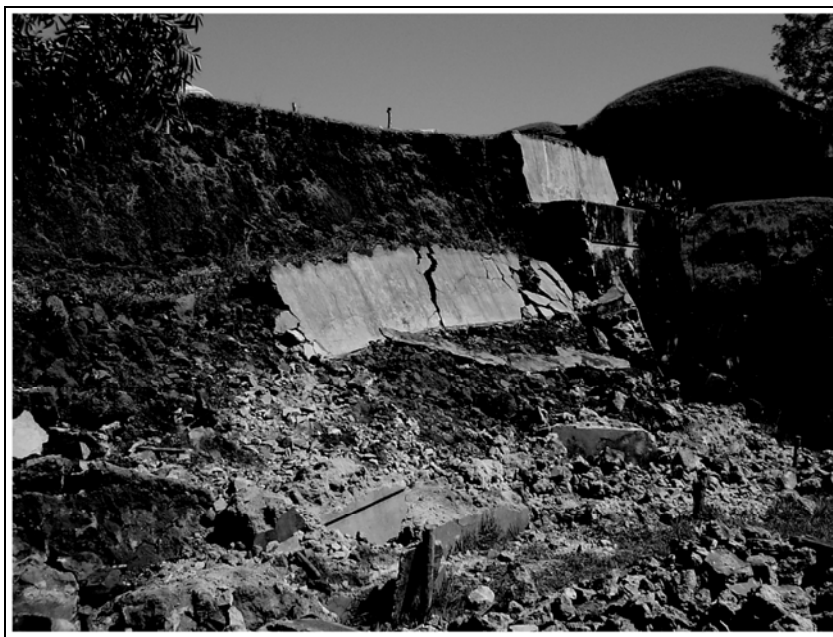
Figura 2 Derrumbe sucedido el 18 de octubre, 2004 (hacia el este)
