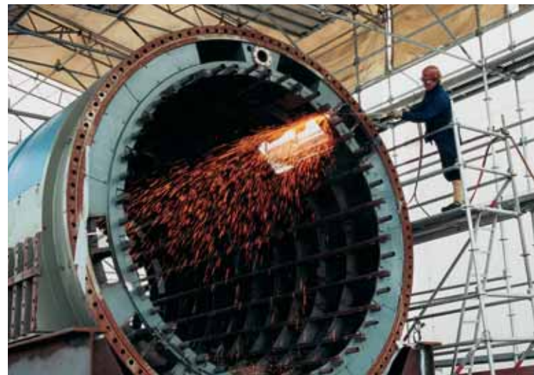
Zerlegung des Generatorständers
