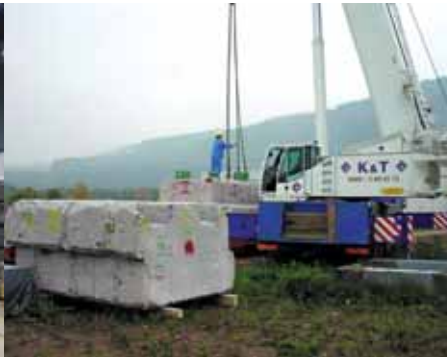
Verladerarbeiten auf dem Kraftwerksgelände
