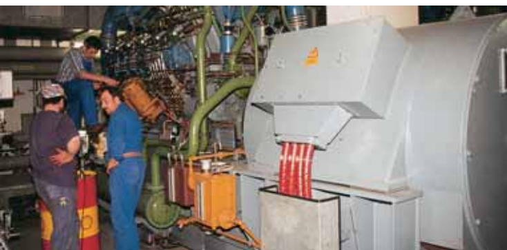
Abbau der Notstromaggregate
