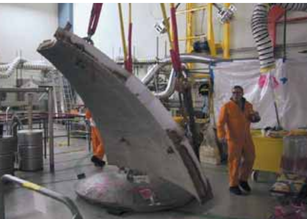
Kuppelsegment des Reaktordruckbehälterdeckels
