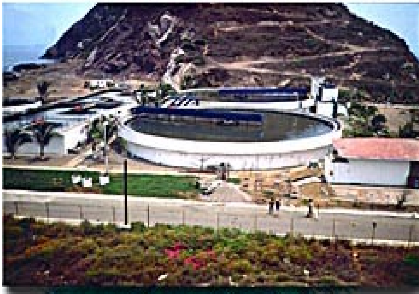
Vista de una planta de tratamiento primario, la cual ha resultado insuficiente para tratar las aguas municipales en Mazatlán, Sinaloa (fotografía del autor).
