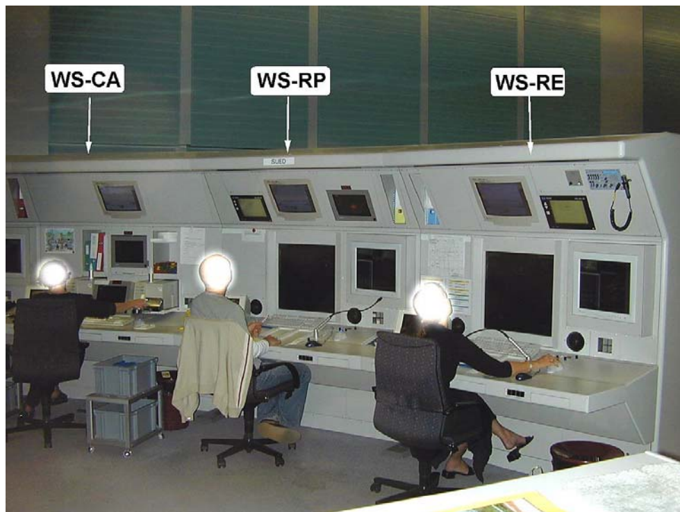
Blick auf die drei Arbeitsplätze des Sektors SUED im Kontrollraum des ACC Zürich. (Während der Nachtschicht vom 1.7. zum 2.7. 02 war der gesamte Luftraum des ACC Zürich auf den Arbeitsplatz RP (128,050 MHz) und der ARFA-Sektor auf den Arbeitsplatz RE (119,920 MHz) geschaltet)
