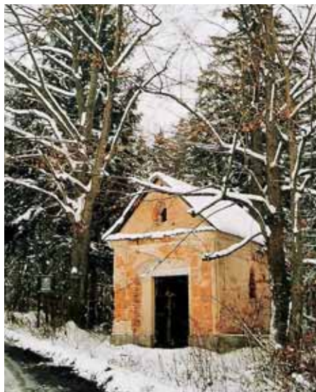
Lesní kaple, u které vrazi odpočívali. Stav v listopadu 2005. Foto: autor
