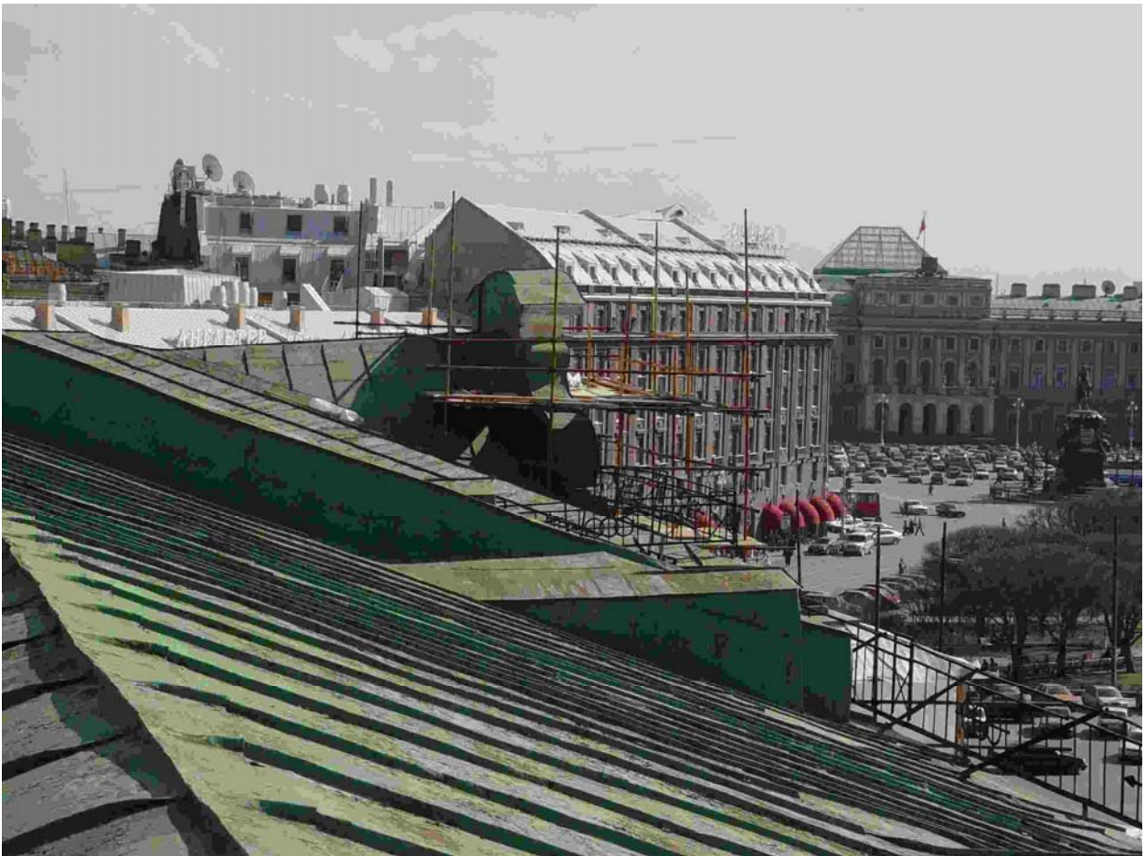
37. Дом Лобанова-Ростовского. Кровля. 2004 г
