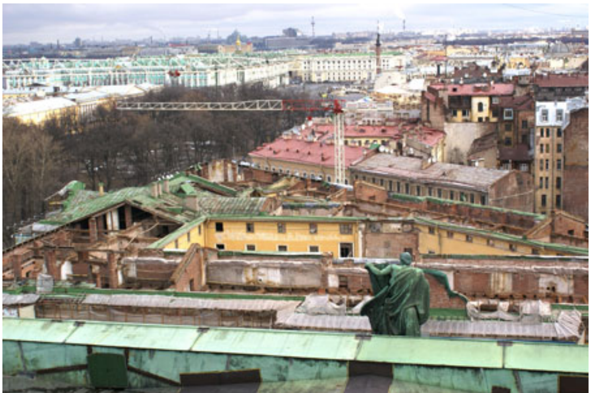
42. Работы по разборке кровли без устройства защитного укрытия. Март 2008 г.
