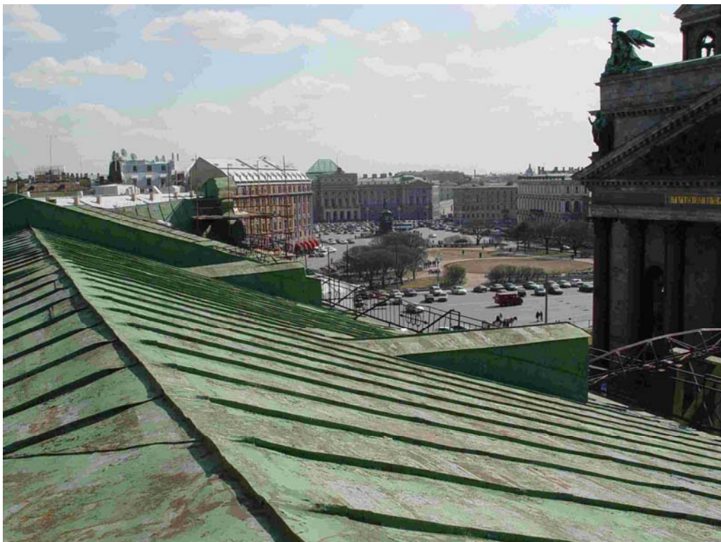
38. Дом Лобанова-Ростовского. Кровля. 2004 г
