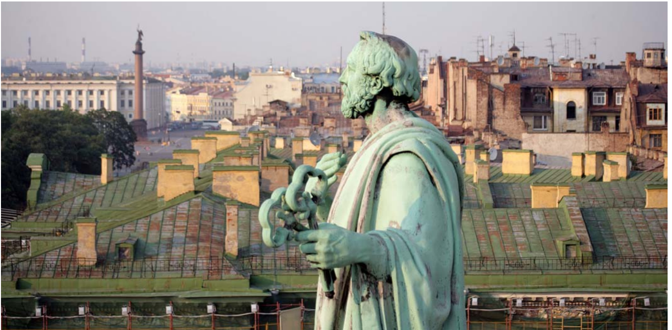
41. Дом Лобанова-Ростовского. Вид на кровлю здания с коллонaды Исаакиевского собора. 2003 г
