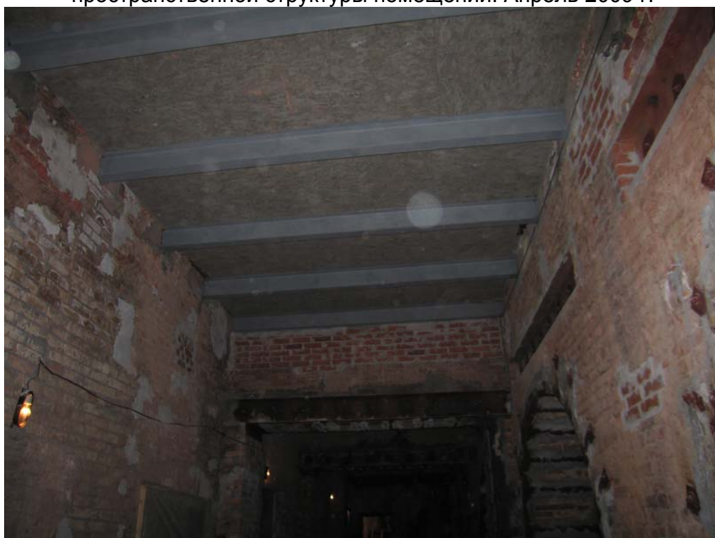
18. Дом Лобанова-Ростовского. Устройство новых перекрытий. Полное удаление штукатурки со стен и потолков. Апрель 2009 г.
