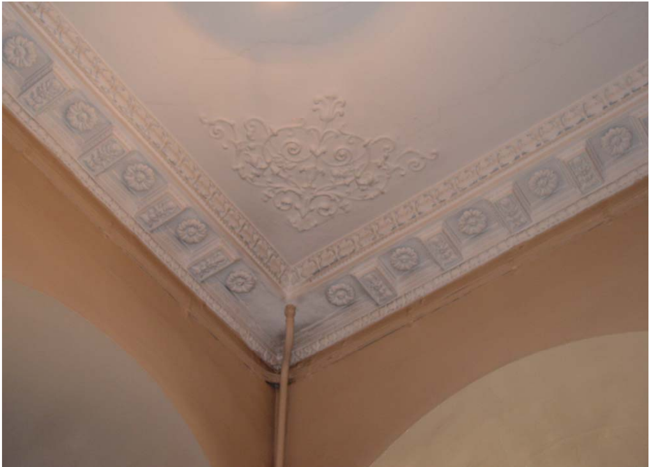
14. Дом Лобанова-Ростовского. Интерьер Углового зала большой анфилады 1-го этажа северного главного корпуса (помещение 5). Карниз из дентикул и розеток, по углам лепные композиции треугольного очертания из рокайлей. 2004 г.
