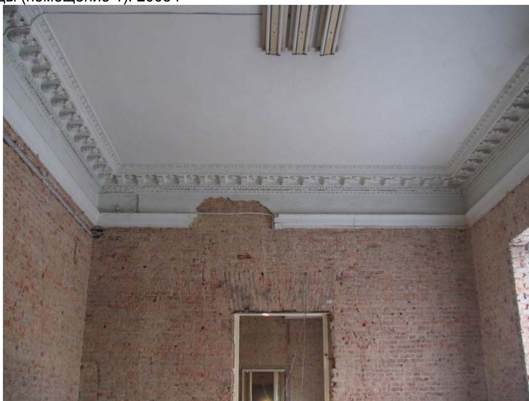
3. Дом Лобанова-Ростовского. Интерьер зала малой анфилады к западу от парадной лестницы (помещение 1). 2005 г
