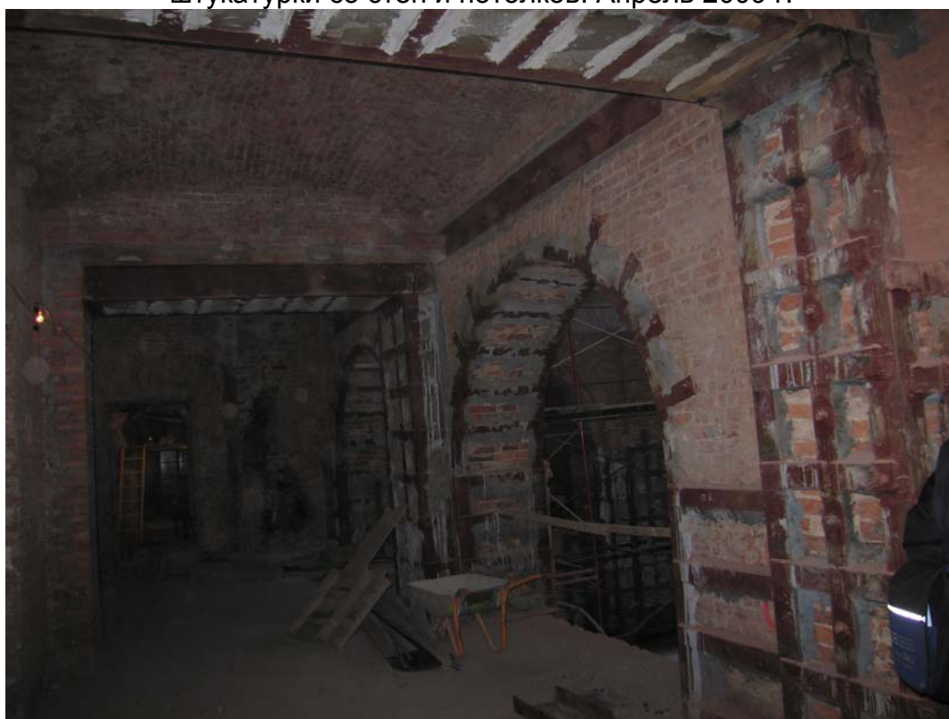
20. Дом Лобанова-Ростовского. Усиление кирпичной кладки металлическими конструкциями. Полное удаление штукатурки со стен и потолков. Апрель 2009 г.
