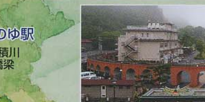
明治44年建造の変電所は、国の重要文化財です。左手は、アプトの道とトロッコ列車の中間駅、まるやま駅。
