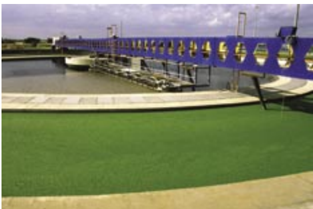
Slika 3: Usedalnik in razdelnik vode v zadnji fazi čiščenja (reciklaže) v čistilni napravi pri Tel Avivu, kjer letno prečistijo 120 milijonov m 3 vode letno. Temu sledi gravitacijsko precejjanje vode skozi peščene morske sipine ter črpanje prefiltrirane vode do nadaljnjih uporabnikov (foto: Peter Frantar).
