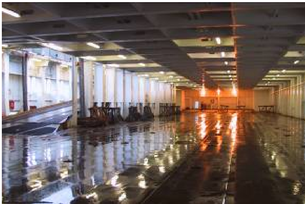
Figur 3 Ovanstående bild är tagen ombord på systerfartyget M/V Finnforest vid lastning i Helsingfors i december 2006, och visar vattenansamling på Upper Deck vid regn.
