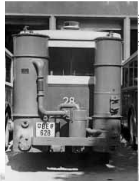
Zur Ueberbrückung der Versorgungslücke während des Zweiten Weltkrieges wurden mehrere Omnibusse auf Holzgasbetrieb umgerüstet
