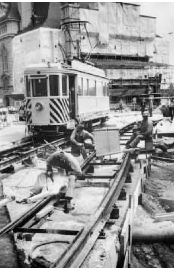
Seit einigen Jahren werden Tramgleise in konzentrierter Bauweise erneuert (Casinoplatz 1988)
