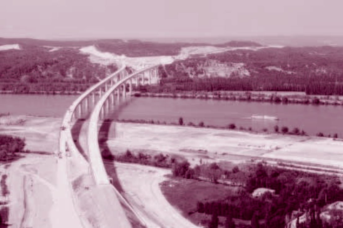
Le double viaduc d'Avignon
