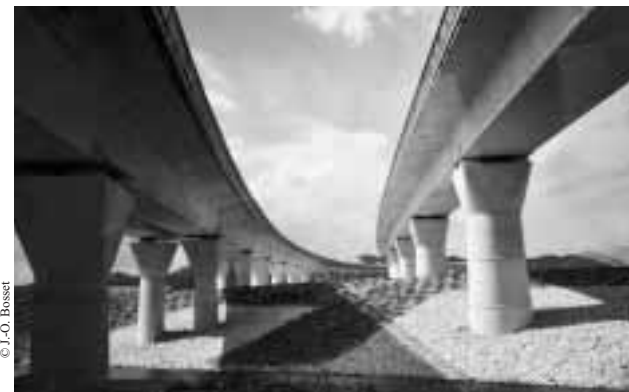
Exemple d'une architecture réussie
