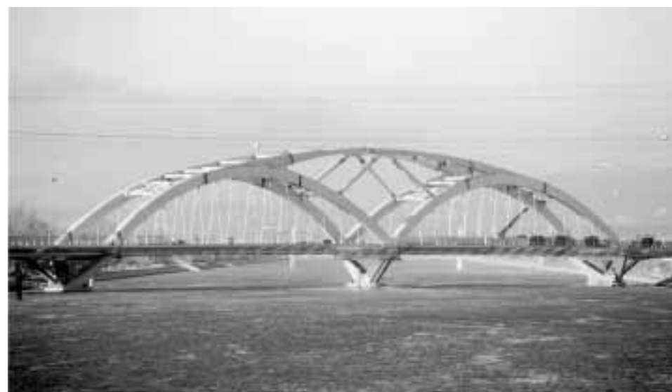
Le double «bow-string» d'acier de La Garde Adhémar
