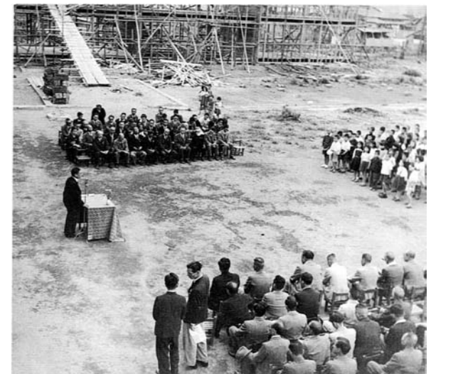
本町小の校舎上棟式 昭和23年（1948年）
