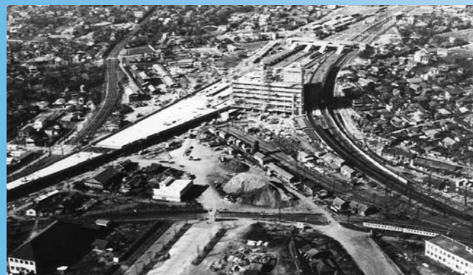
移転工事中の国鉄千葉駅 昭和38年（1963年）4月28日に開業しました。（昭和38年〔1963年〕1月撮影）
