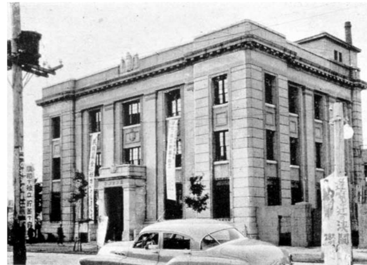
第九十八銀行本店 大正14年（1925年）5月の新築。この建物は、昭和18年（1943年）3月31日合併により「千葉銀行」が誕生し、本店として昭和48年（1973年）3月まで使われ、その後、同行中央支店として使われました。
