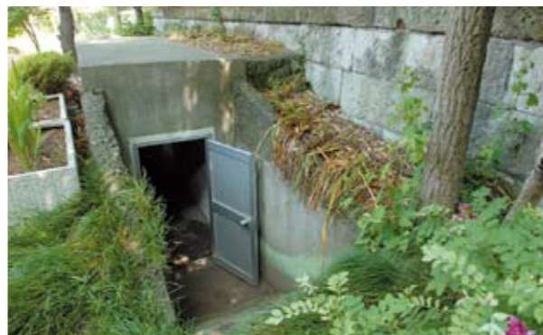
「千葉市ゆかりの家・いなげ」敷地内に現存する防空壕(外観) 通常は、崖地に素掘りの「横穴式防空壕」であったが、コンクリート製のものは、珍しい。
