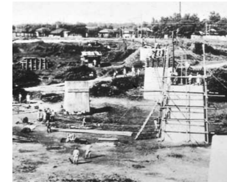
橋脚が破壊された場合の復元訓練風景で、現在の千葉公園内少年野球場付近です。
