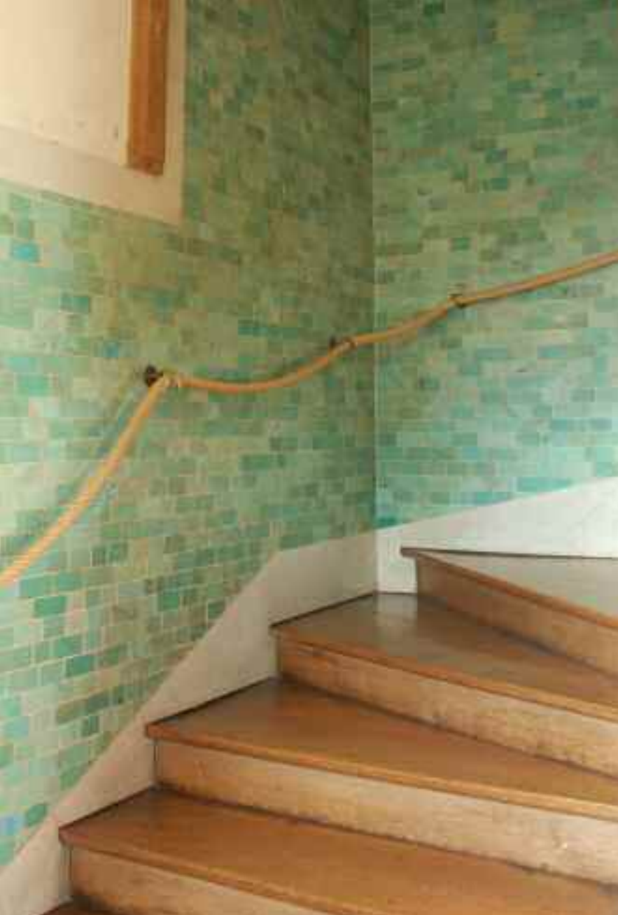
fig. 19 L'Escalier bleu, aux murs revêtus de carreaux de pâte de verre. The Blue staircase with its walls covered in glass tiles.
