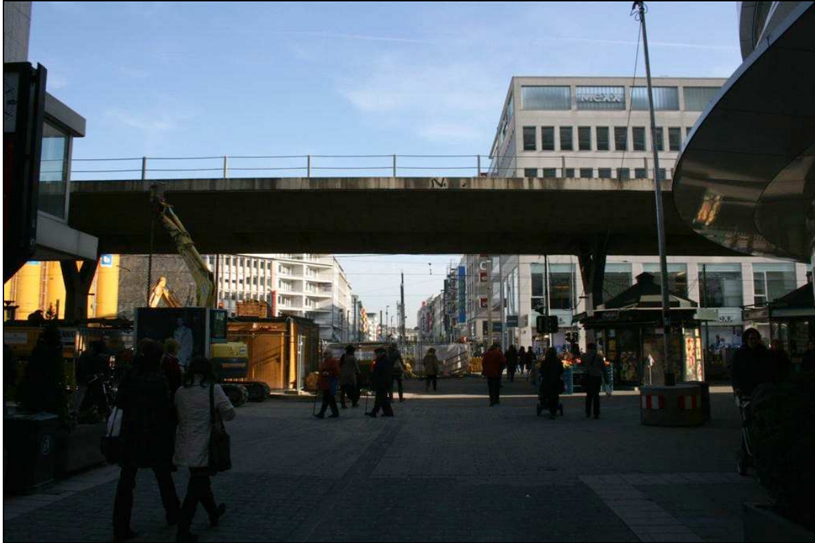
Abb. 4. Blick die in Schadowstraße auf die kreuzende Hochbrücke. Foto: Dahms 9.02.2011.
