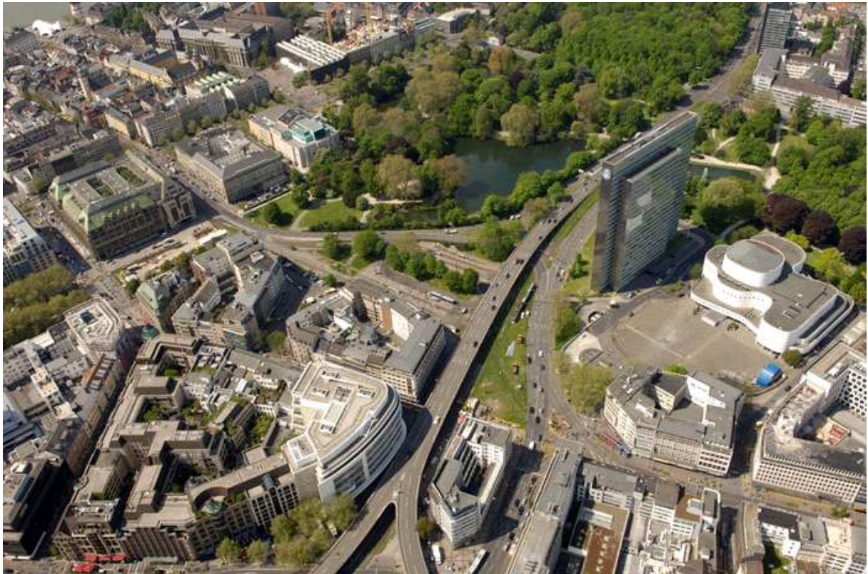
Abb. 2. Luftbild der Hochstraße Jan-Wellem-Platz mit Hofgarten und Landskrone, Dreischeibenhochhaus und Schauspielhaus. Quelle: Auftraggeberin.
