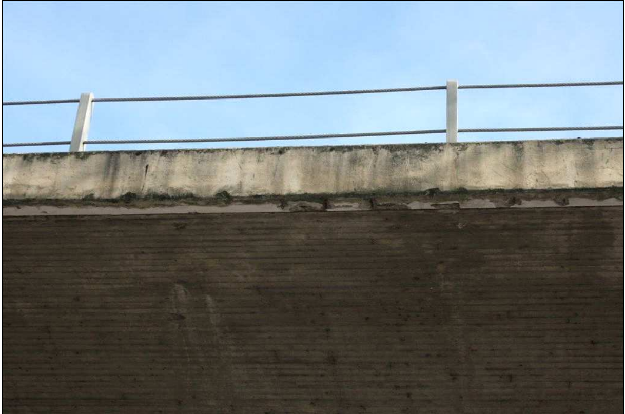
Abb. 17. Unterkonstruktion und Gesimsband der Hochstraße mit Schadensbild (Korrosion, Feuchtigkeit, Algenbewuchs, Rissbildung, Abplatzungen). Foto: Dahms 9.02.2011.
