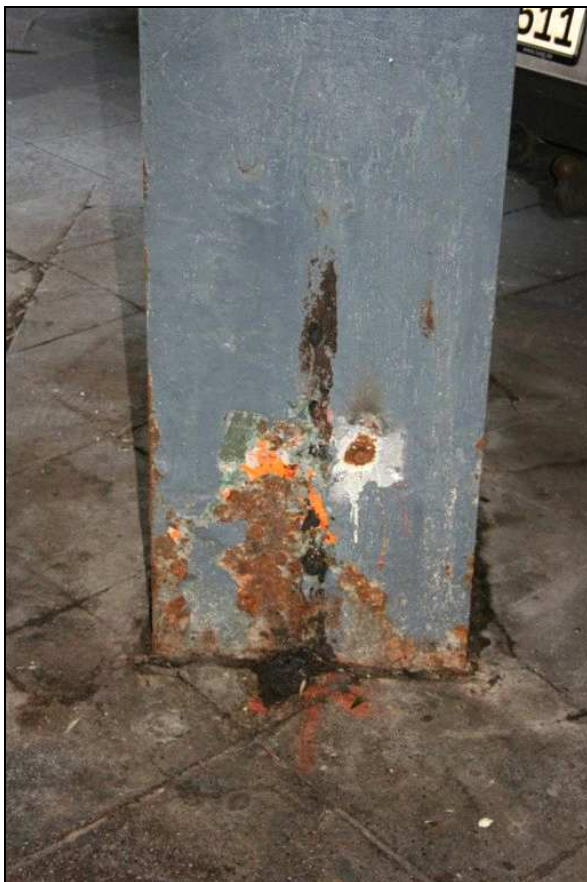
Abb. 17. Unterkonstruktion und Gesimsband der Hochstraße mit Schadensbild (Korrosion, Feuchtigkeit, Algenbewuchs, Rissbildung, Abplatzungen). Foto: Dahms 9.02.2011.
