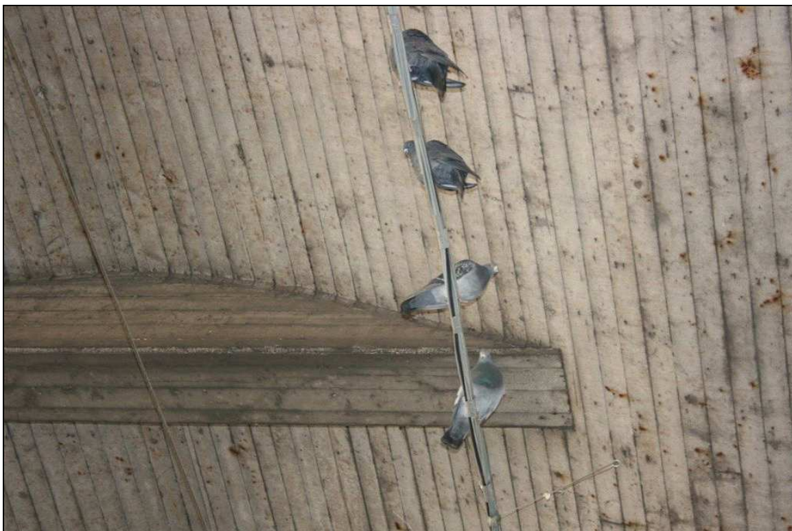
Abb. 14. Unterkonstruktion der Hochstraße mit Schadensbild (Korrosion). Foto: Dahms 9.02.2011.
