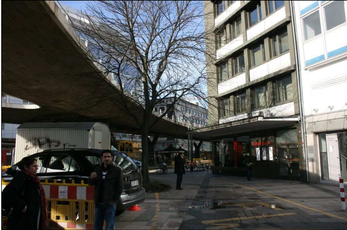
Abb. 8. Hochstraße Jan-Wellem-Platz, Abzweig Immermannstraße, Berliner Allee. Foto: Dahms 9.02.2011.
