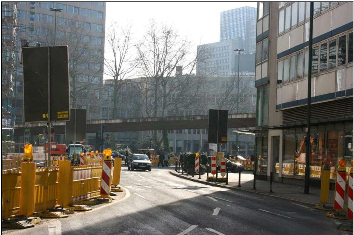
Abb. 24. Blick Richtung Börse auf die Hochstraße. Foto: Dahms 9.02.2011.
