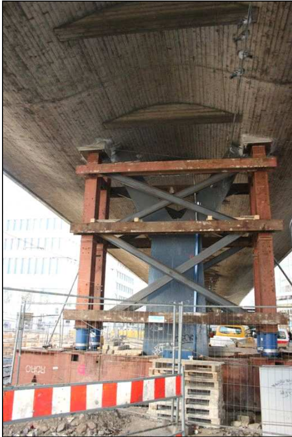
Abb. 12 und 13. Untersicht Hochstraße Jan-Wellem-Platz mit Stützkonstruktion zur Verstärkung der Stahlstützen und zur Herstellung der Standsicherheit. Foto: Dahms 9.02.2011.
